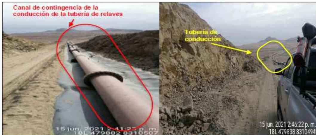
Fotografía N° 1. Vista del canal de contingencia de la tubería de conducción de relaves.
