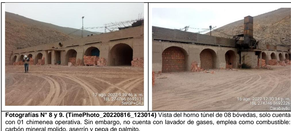
**Fotografías N° 8 y 9. (TimePhoto\_20220816\_123014)** Vista del horno túnel de 08 bóvedas, solo cuenta con 01 chimenea operativa. Sin embargo, no cuenta con lavador de gases, emplea como combustible: carbón mineral molido, aserrín y pepa de palmito.
