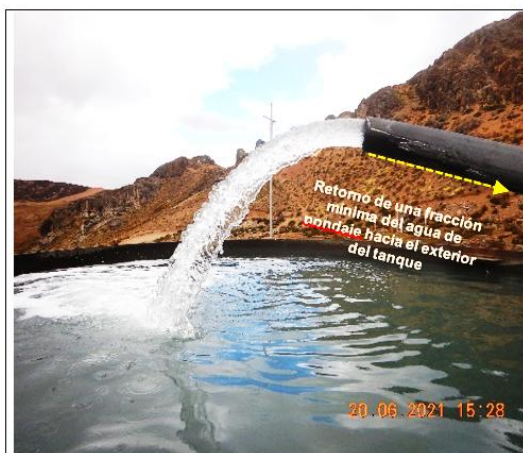
Fotografía N° 36 Parte superior del Tanque N° 1 en donde se observa la llegada del pondaie del depósito de relave. Fotografía del 20 de junio de 2021
