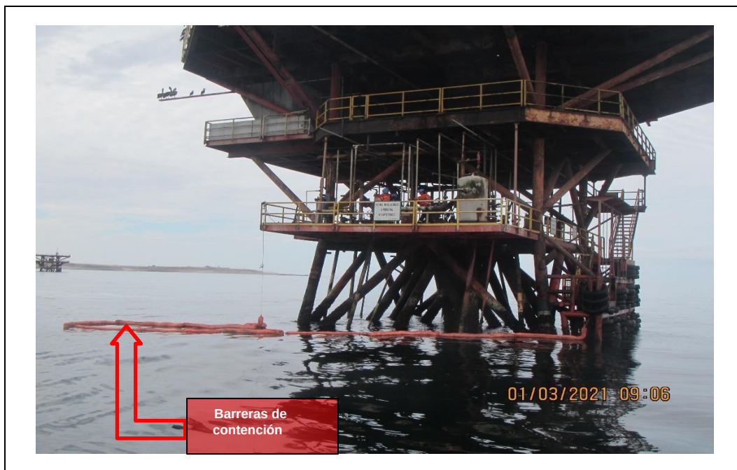
Cuadro N° 57: Evidencia de barreras de contención (salchichas) en el agua de mar, Colindantes a la plataforma H
