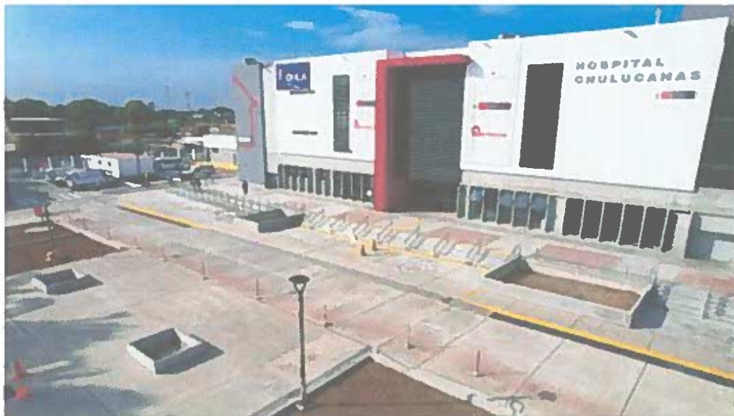
Figura 1. Imagen hospital Chulucanas.
