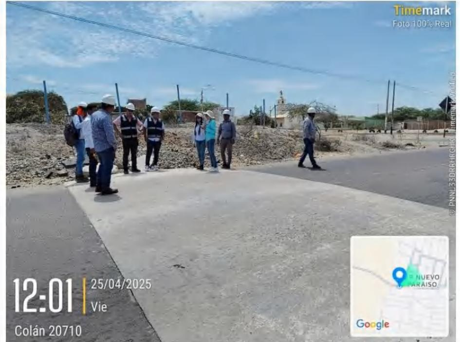
En este reductor de velocidad apreciamos un desgaste excesivo de la pintura, como se puede apreciar en las fotos es casi nula la pintura restante.
