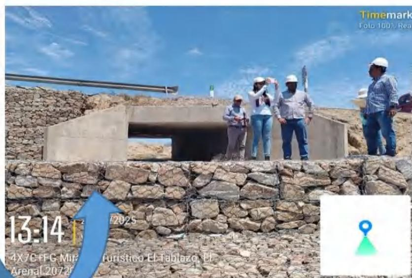
En la progresiva 66+963 junto a los ingenieros del área de estudios y proyectos de la Dirección Regional de Transportes y Comunicaciones se constató los trabajos de construcción de muros de gaviones, para soportar el terraplén erosionado, así mismo para estabilizar el talud y contener las masas de tierra.
