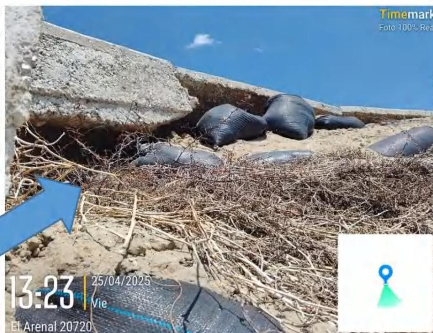
Dentro del recorrido en el km 66 +980 se visualiza Erosión en la parte lateral del talud de la alcantarilla, **se recomienda** la construcción de emboquillados para evitar la socavación, erosión o deslizamiento, reforzando y estabilizando la zona.
