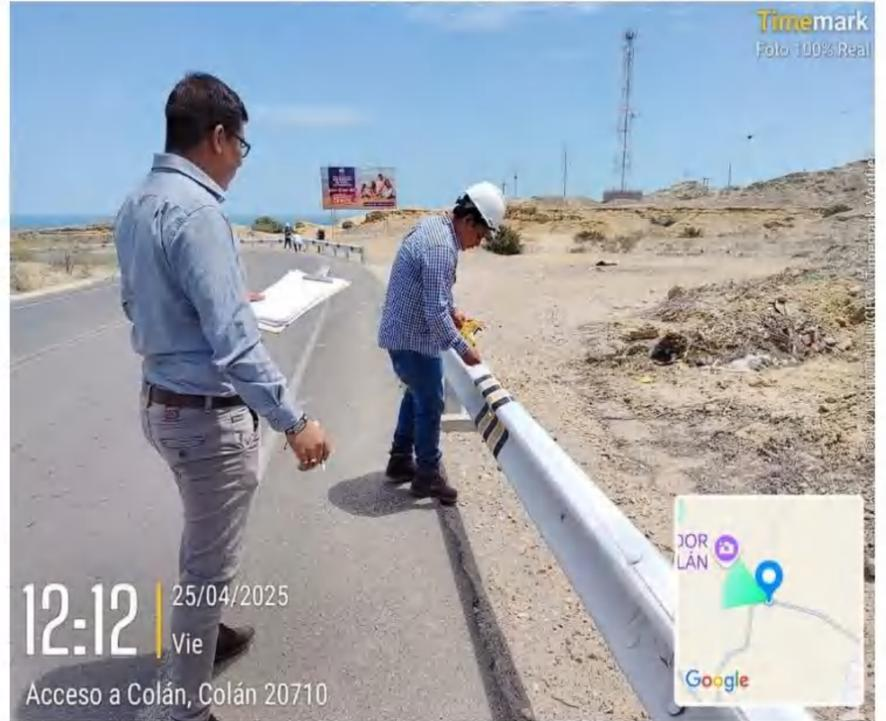
Se realizó la medición correspondiente del metraje de las guardavías, así mismo se aprecia en la foto que los muros de concreto de las barandas de las guardavías se están desprendiendo de su colocación inicial, se recomienda verificar su proceso constructivo.
