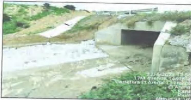
FOTOGRAFIA 21.- PRO TECCION COLAPSADA DE ALCANTARILLA N° 01 – KM 66+963
