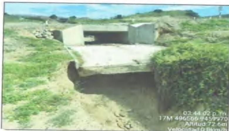
FOTOGRAFIA 23.- CUNETETA COLAPSADA N° 02 EN LADO IZQUIERDO DE LA VIA – KM 66+711
