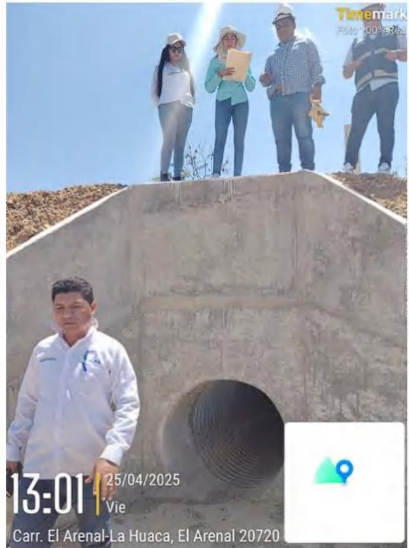
Mediante las fotos se constata la verificación de los trabajos en las alcantarillas, Esta partida se refiere a limpiar las alcantarillas metálicas, de concreto u otros materiales, con la finalidad de eliminar toda basura, sedimento, material de arrastre u otros que obstaculicen u obstruyan el libre flujo del agua, evitando estancamientos perjudiciales para la vía, siendo por tanto un trabajo permanente que se realiza mecánica o manualmente.
