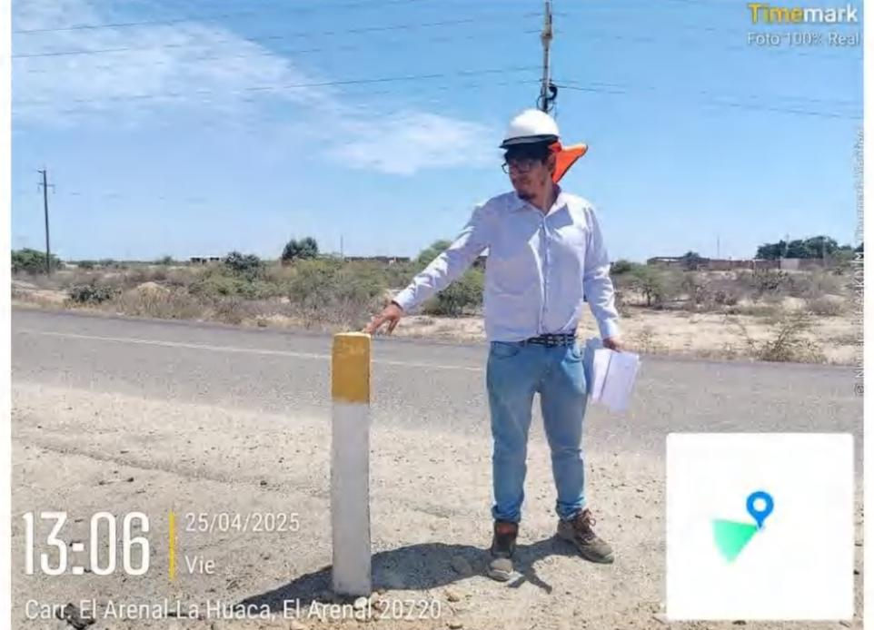
El trabajo de conservación y/o reposición de postes delineadores consiste en la colocación de nuevos elementos de seguridad vial, en lugares puntuales, a fin de mantener la funcionalidad de la vía y guiar a los conductores, en condiciones de baja visibilidad o en áreas de curvas, ayudándoles a identificar los límites de la Carretera.
