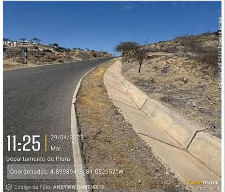
Dentro de la ficha técnica se han identificado 8156.37 ml de limpieza de cunetas en la provincia de Paita. Es necesario la limpieza de cunetas para prevenir inundaciones , erosión y prolongar la vida útil de la carretera .
