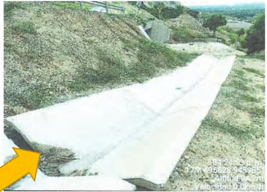
Como se muestran en las imágenes comparativas, hay una alcantarilla en el que descargan dos cunetas tanto en LD y LI, las mismas que colapsaron por socavación del terreno de fundación y se destruyeron.
