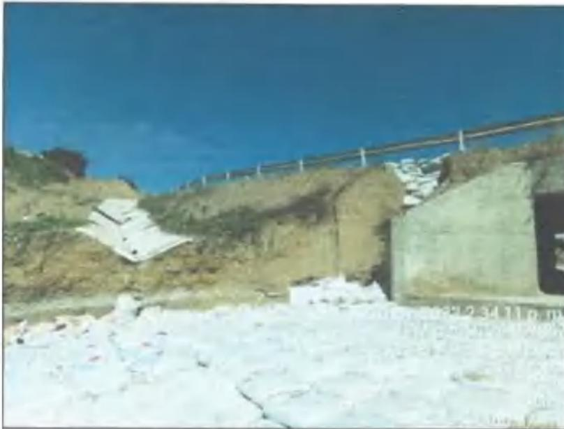
FOTOGRAFIA 25.- CUNETETA COLAPSADA N° 02 EN LADO IZQUIERDO DE LA VIA – KM 67+500
