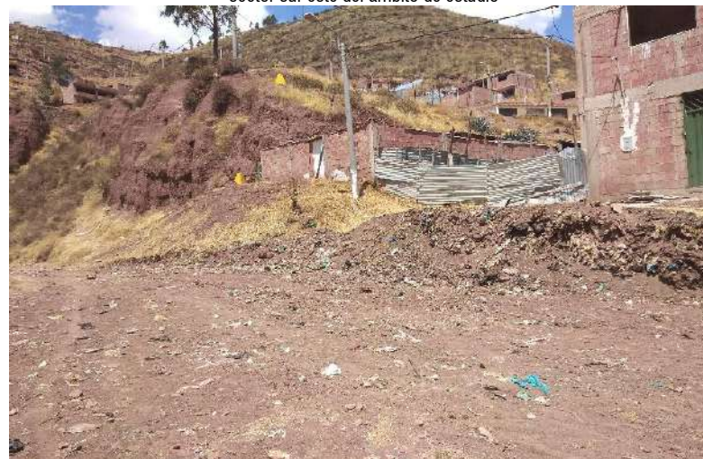
Imagen N° 128: Registro de la presencia de residuos en áreas cercanas al cuerpo de agua, sector sur este del ámbito de estudio
