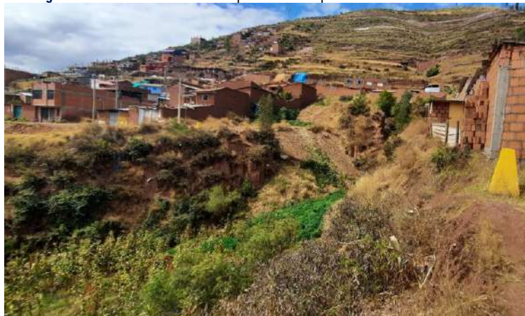
Imagen N° 89: Cultivos en cauce de quebradas con presencia de materiales de relleno
