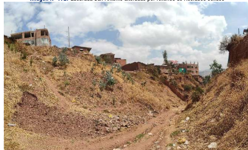
Imagen N° 172: Quebrada San Antonio alteradas por rellenos de Residuos solidos
