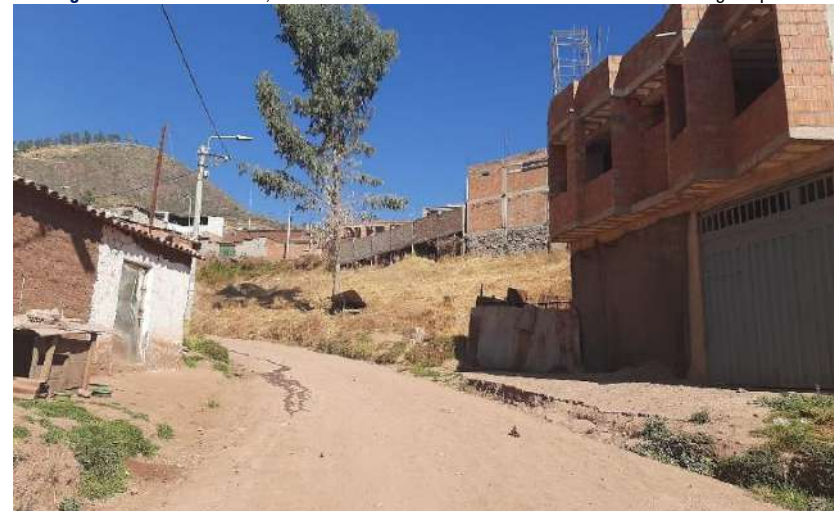
Imagen N° 174: Calle Unión, Vía sin afirmar con ausencia canal de evacuación de aguas pluviales
