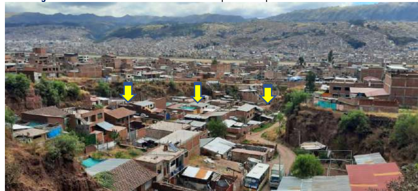
Imagen N° 88: Población asentada en cauce de quebradas que fueron rellenadas con desmorte
