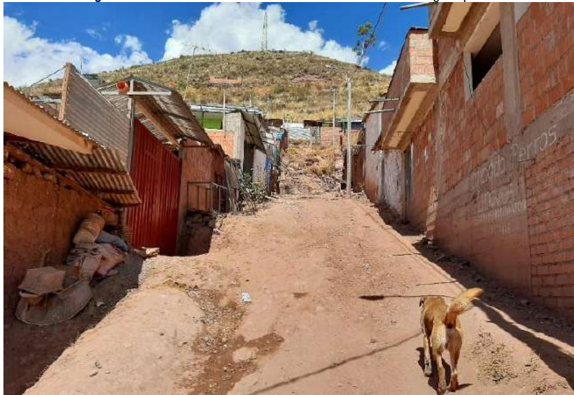
Imagen N° 175: Calle 06 con ausencia canal de evacuación de aguas pluviales
