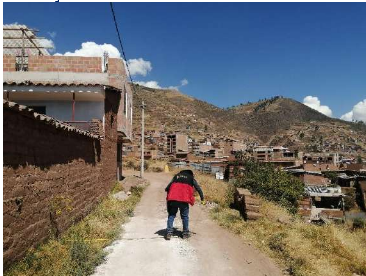
Imagen N° 139: Calle señor de Huanca en estado de conservación malo.
