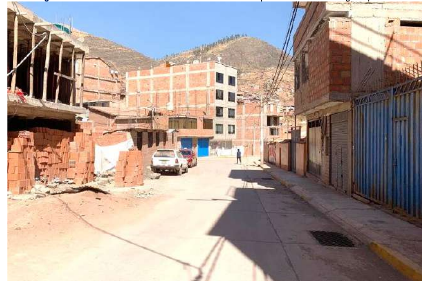
Imagen N° 176: Av. San Antonio con sumideros laterales para evacuación de aguas pluviales
