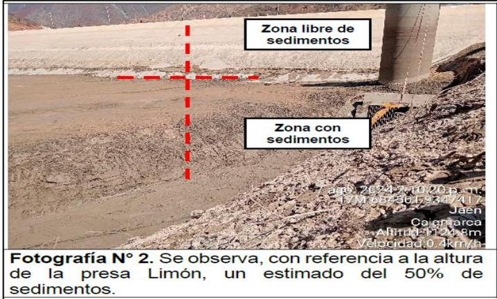
**Fotografía N° 2.** Se observa, con referencia a la altura de la presa Limón, un estimado del 50% de sedimentos.
