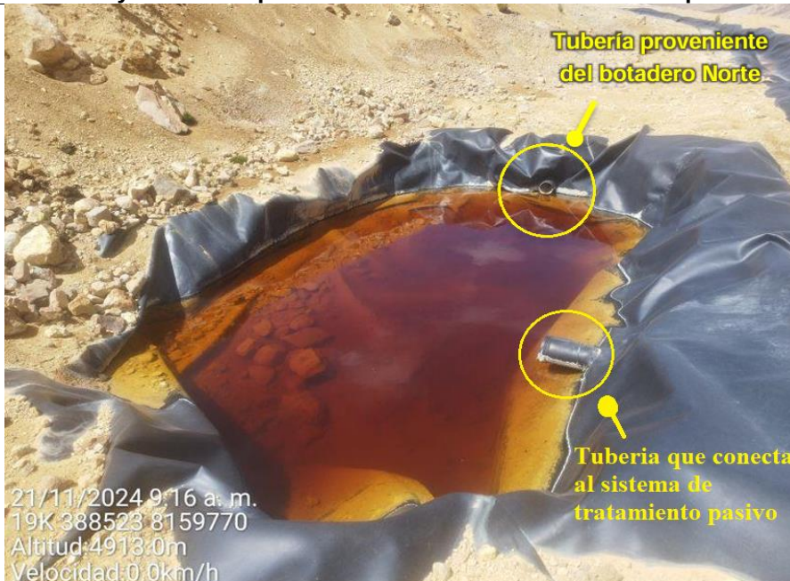
Figura N° 2: Falta de conector entre el tanque N° 2 y N° 3
