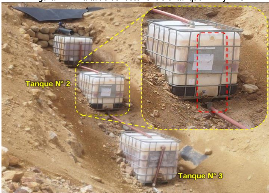
Figura N° 2: Falta de conector entre el tanque N° 2 y N° 3
