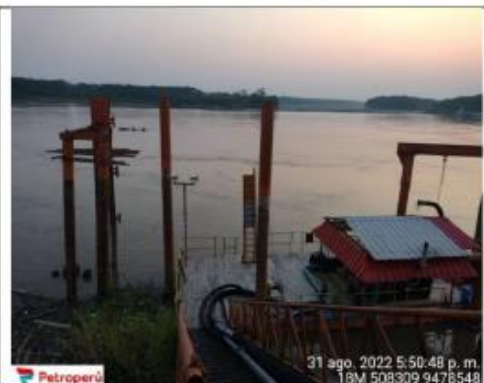
Fotografía N° 2. Vista Panorámica del Pontón 4 en Estación 1. Coordenadas UTM (WGS 84) Zona 18M: N9478548, E508309.
