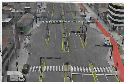
Visualización de la señalización de cruces peatonales. Vista panorámica del Viaducto aéreo - Libertadores (310 m. de longitud) Obra de 6.8 km longitud con 4 vías, 8 carriles, con carpeta asfáltica de e=17 cm en las vías centrales y 13 cm en las vías laterales.
