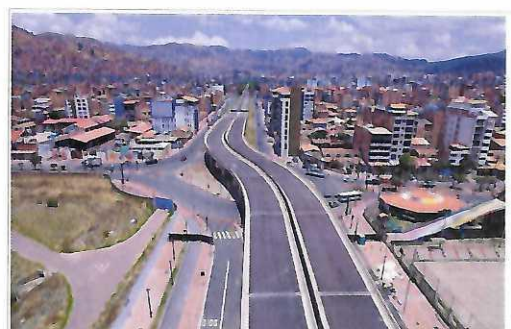
Visualización de la señalización de cruces peatonales. Vista panorámica del Viaducto aéreo - Libertadores (310 m. de longitud) Obra de 6.8 km longitud con 4 vías, 8 carriles, con carpeta asfáltica de e=17 cm en las vías centrales y 13 cm en las vías laterales
