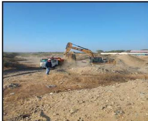
Foto: Se aprecia la demolición de la carpeta asfáltica y la demolición de la carpeta de afirmado con la excavadora.
