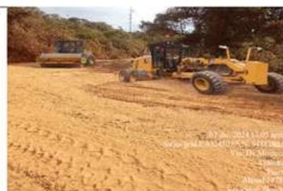
FOTO 39 PERFILADO DE SUPERFICIE SIN APORTE DE MATERIAL PROGRESIVA 18+000 - 18+280
