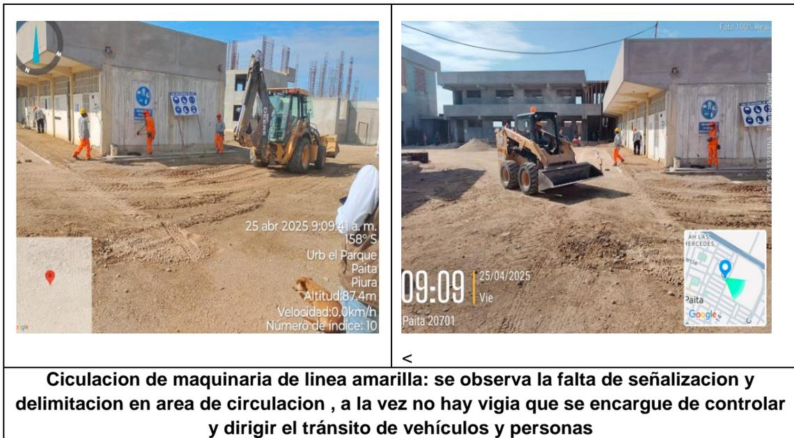
En la imagen que precede se visualiza la circulación de la retroexcavadora y un minicargador, donde se puede apreciar, la falta de señalización, delimitación de áreas de trabajo y falta de vigías, que son necesarias para salvaguardar la integridad física del personal, incumpliendo los siguientes ítems de la **Norma E050 SEGURIDAD DURANTE LA CONSTRUCCIÓN**
