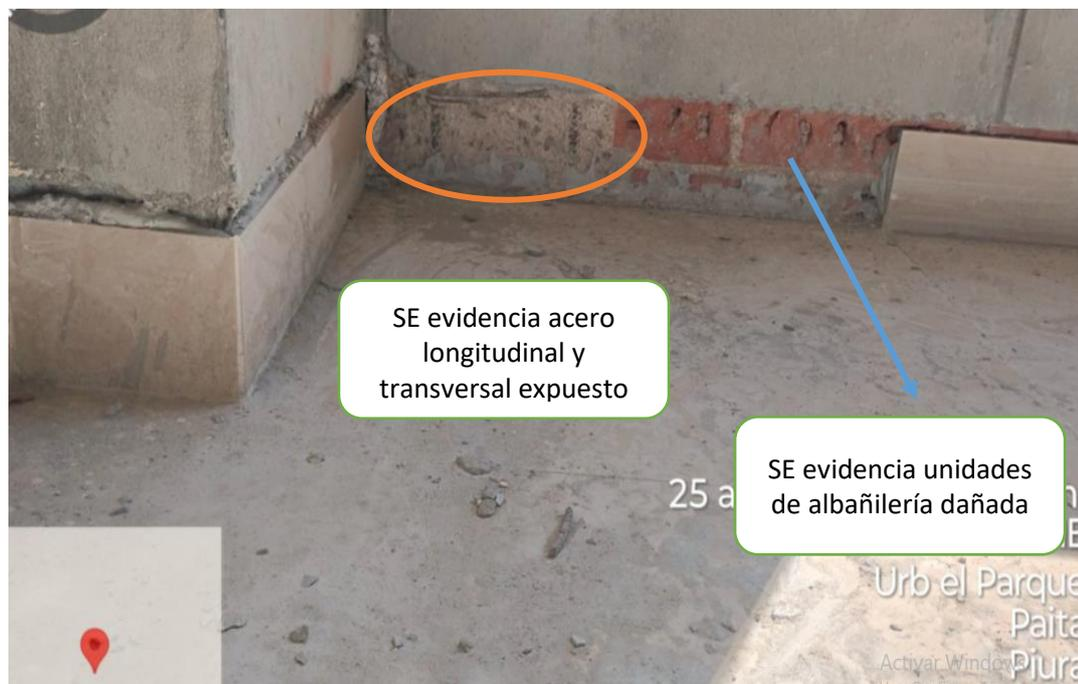
SE evidencia acero longitudinal y transversal expuesto
