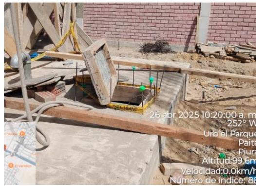
**Falta de Capuchon protector de seguridad : Se observa varillas de acero expuestas, poniendo en riesgo integridad física y salud de los trabajadores y de terceras personas en obra**
