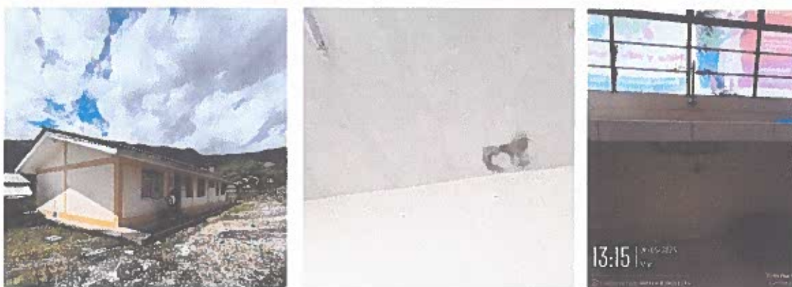
Descripción: Ambientes – Infraestructura Puesto de Salud Charan.
