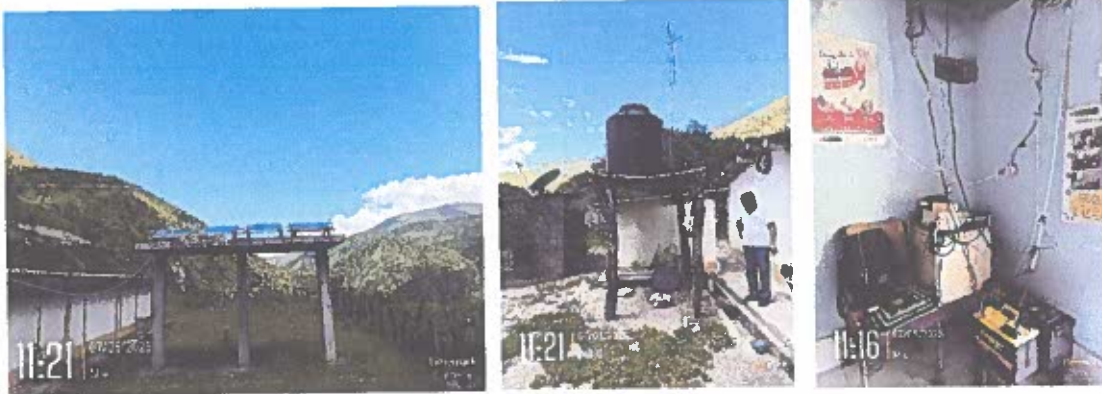
Descripción: Ambientes – Infraestructura Puesto de Salud Sausal.
