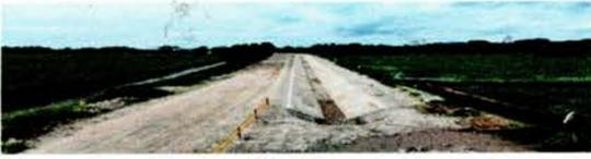
3. Vista detallada del canal principal Luchador Shica revestido con concreto. P.C-175 K57C.M2
