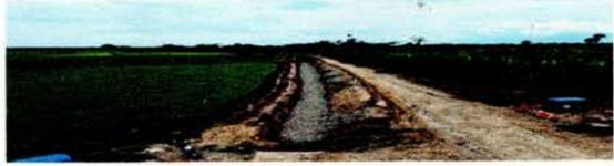
2. Colocación de relleno con sobre 30 cm en capa de canal
