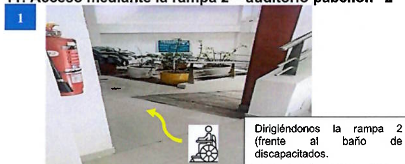
Imagen 11: Acceso mediante la rampa 2 – auditorio pabellón "2"
