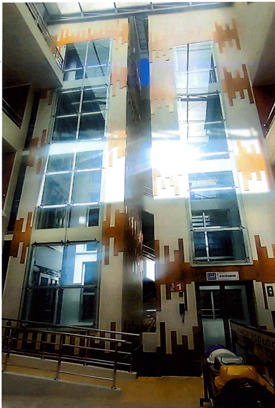
Imagen 08: Ascensores implementados en la Sede Central de la UNDAR
