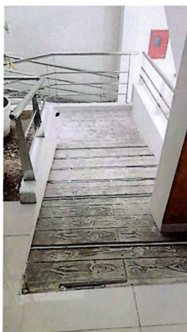
Imagen 15: Barandas para el ingreso al auditorio
