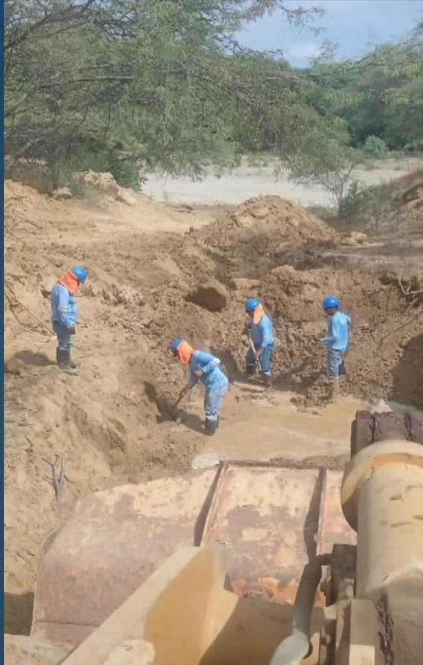
MAQUINARIA. La maquinaria (Retroexcavadora) se brinda el apoyo a OTASS; para realizar la excavación y así los técnicos realicen la reparación de la rotura en la tubería en diferentes puntos. ATENCIÓN INMEDIATA.
