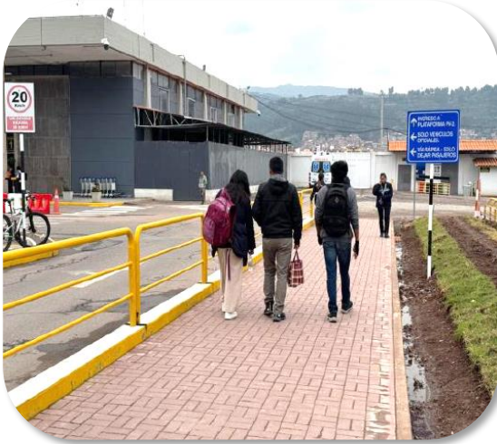
Mejoramiento y ampliación de veredas de acceso al terminal de pasajeros
