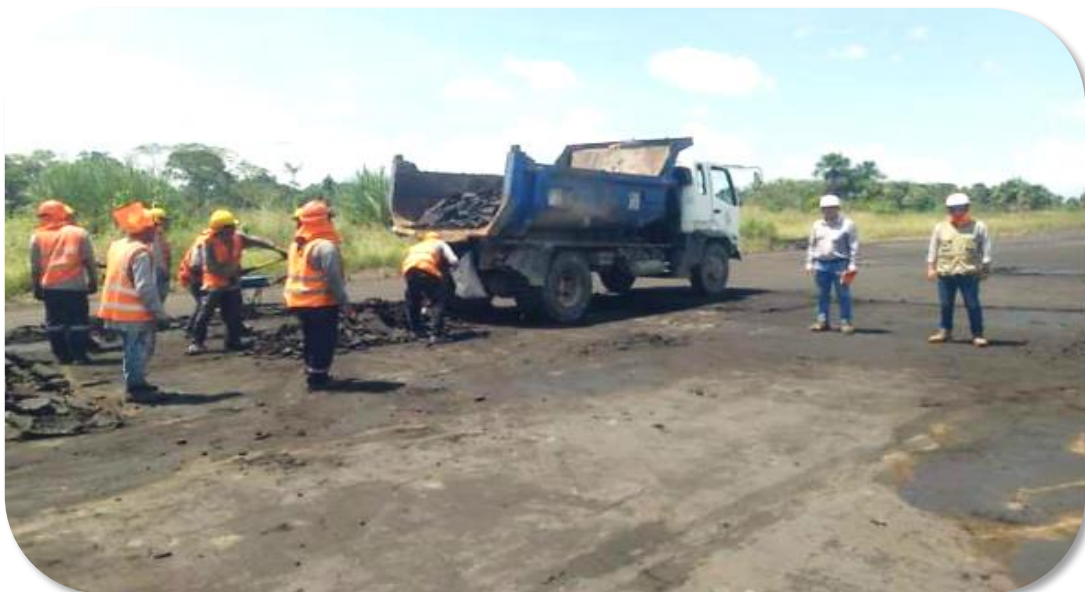
Nivelación y fresado de pavimento en el Aeródromo de Caballococha
