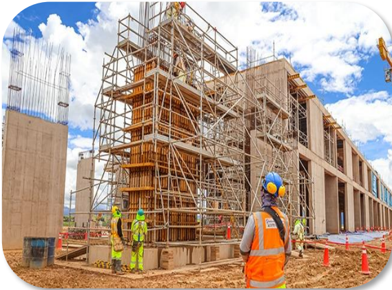
Avance obras del terminal
