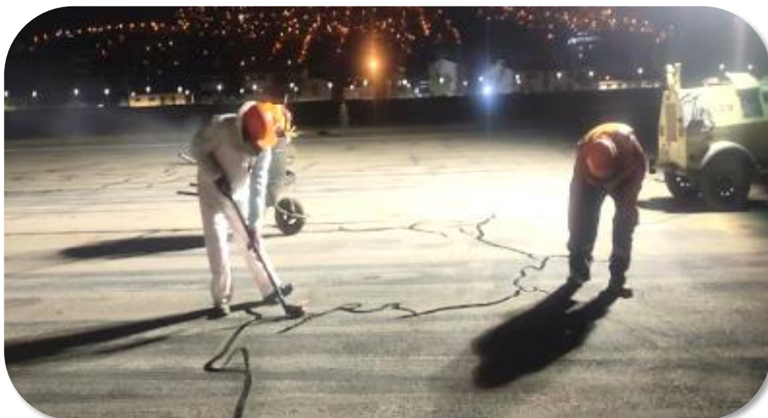
Tratamiento de fisuras en la pista de aterrizaje
