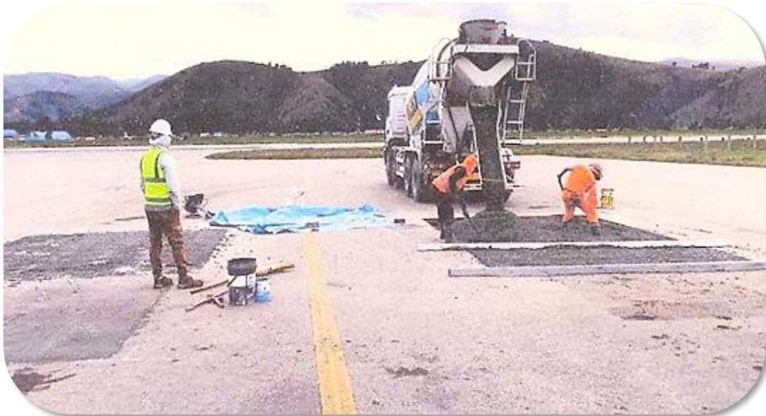
Vaciado de concreto para resistencia estructural en pavimento del Aeropuerto de Jauja
