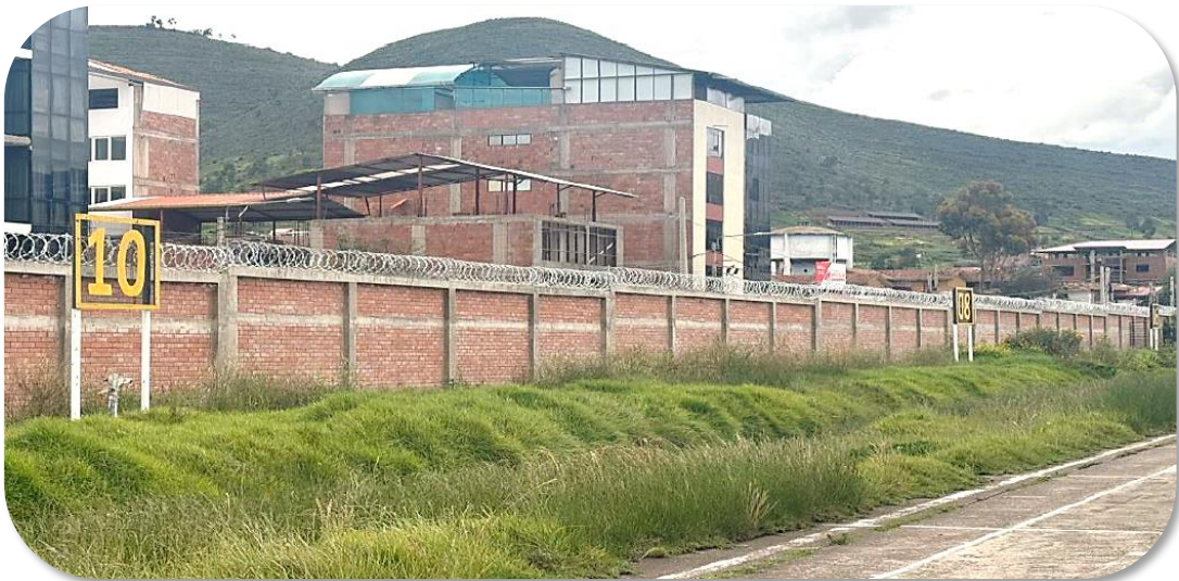
Concertinas de seguridad en el cerco de la plataforma de estacionamiento de aeronaves
