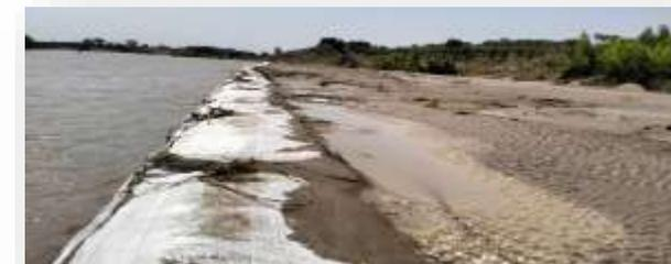
Descolmatación y ensanchamiento del cauce de 40 a 110 m para mejorar la capacidad hidráulica.
