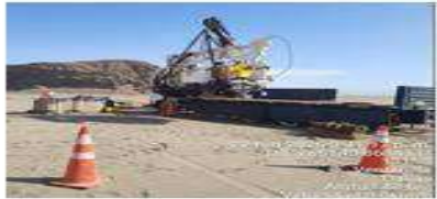
Inicio de la perforación de piezómetros
