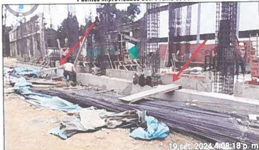
Fotografía n.º 9 Puentes improvisados sobre ruma de acero
