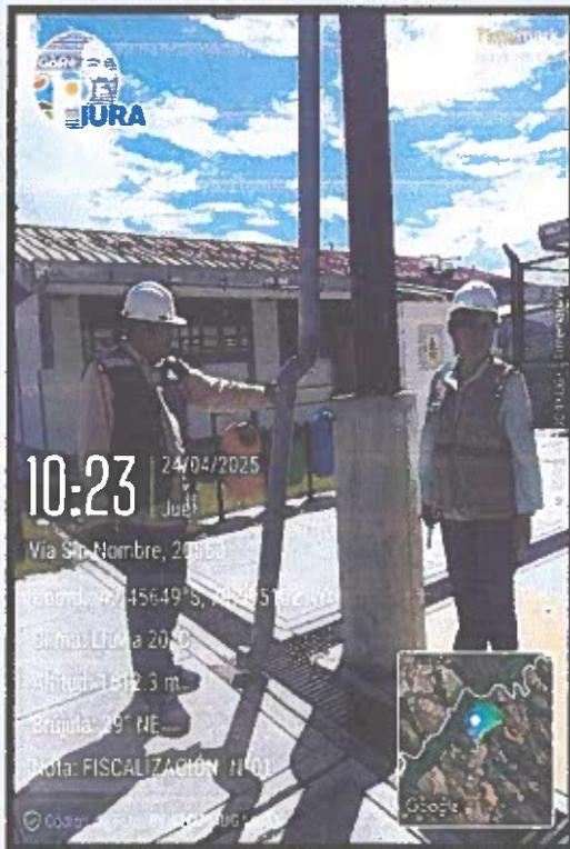
Imagen 11: Vista de tubería de drenaje pluvial no se encuentran sujetadas
