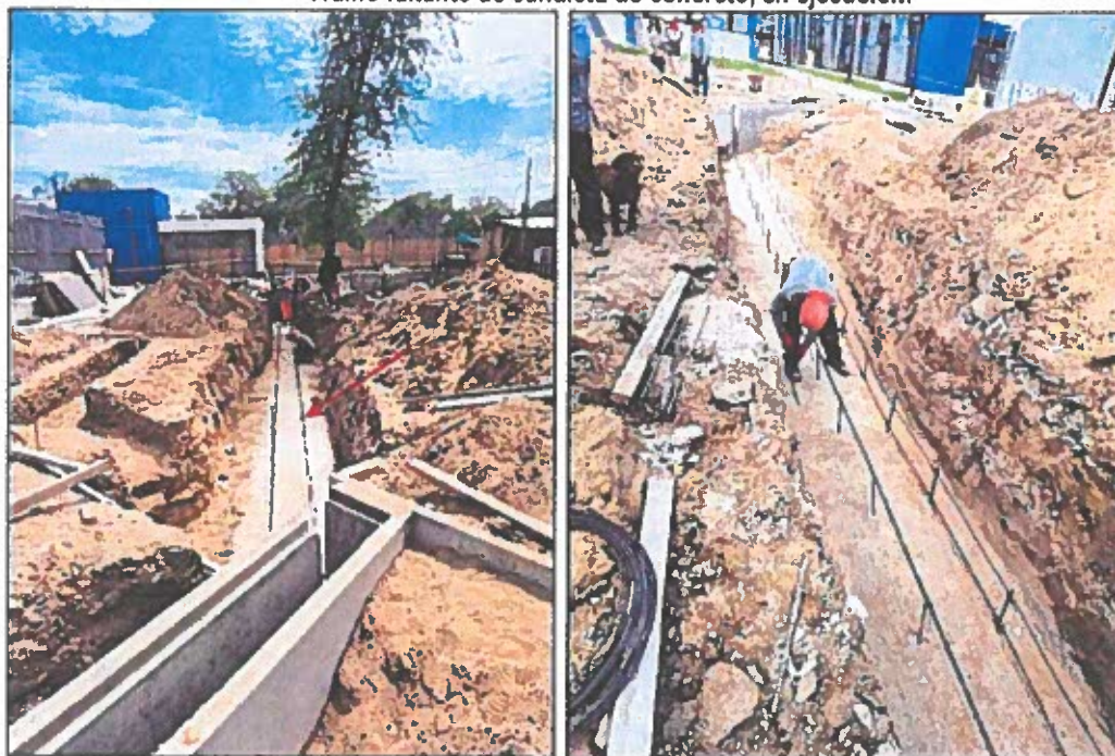
Fotografías n.º 4 y 5 Tramo faltante de canaleta de concreto, en ejecución.
