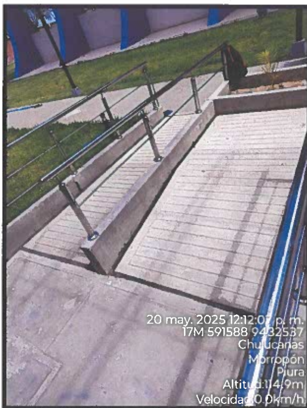
Descripción: Rampas instaladas en el auditorio.
