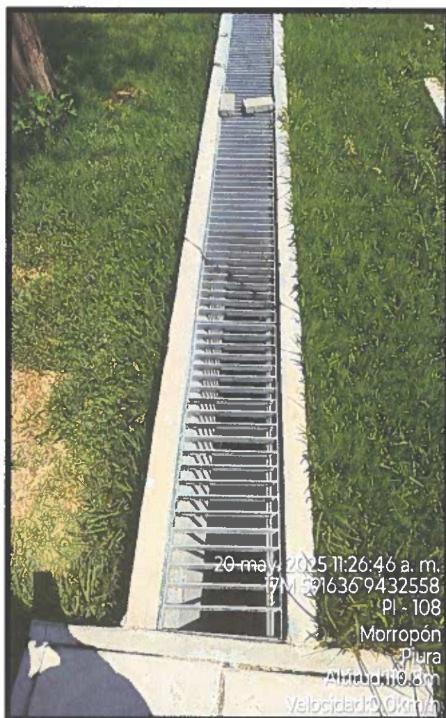
Descripción; Culminación de las canaletas y rejas del drenaje.
