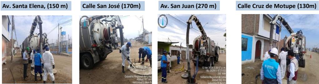
Siendo un total de 720 m de longitud, acciones que fueron articuladas y ejecutadas a fin de dar mantenimiento con equipo Hidroject a las redes colectoras y así evitar obstrucciones y/o sedimentaciones del servicio
