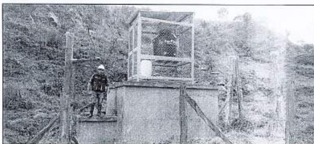
IMAGEN 2: EQUIPO DE CLORACION INSTALADO EN SISTEMAS DE AGUA
