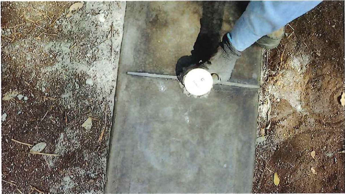
Ilustración 26: Incrustación del disco de bronce
