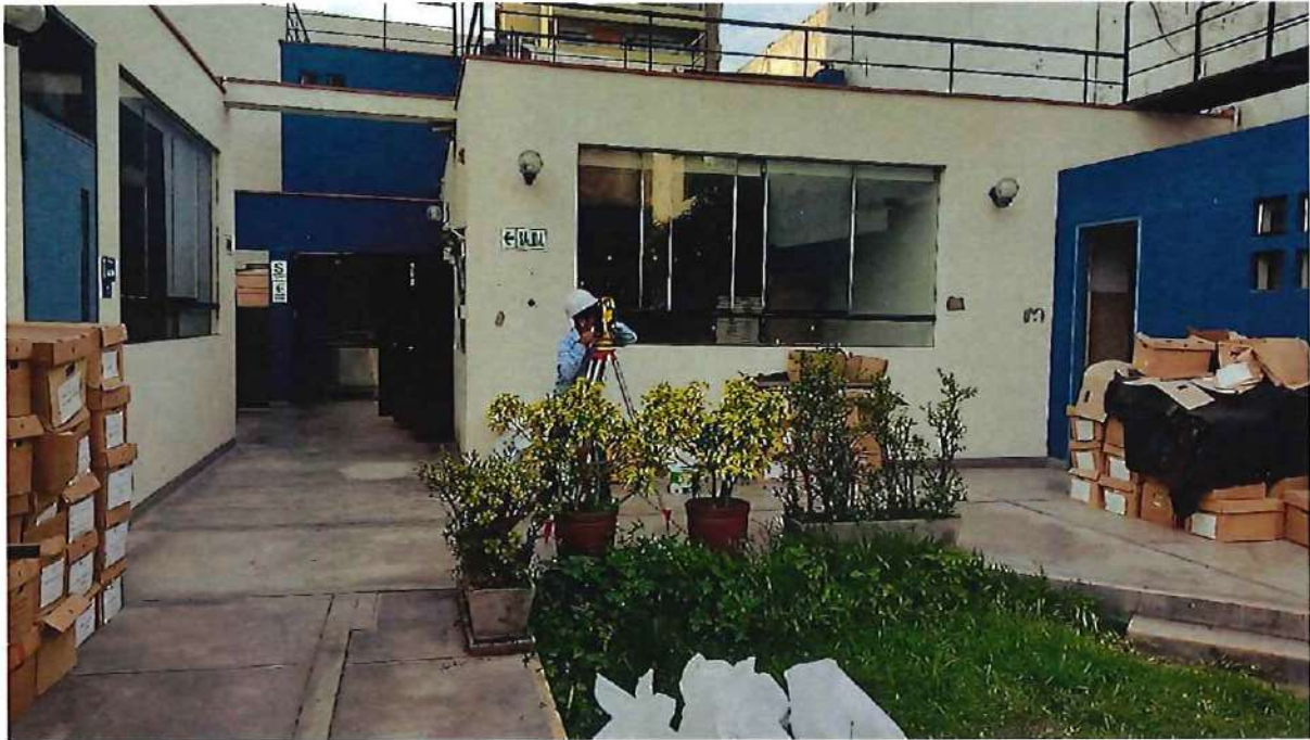
Ilustración 30: Topografo operando la Estación Total
