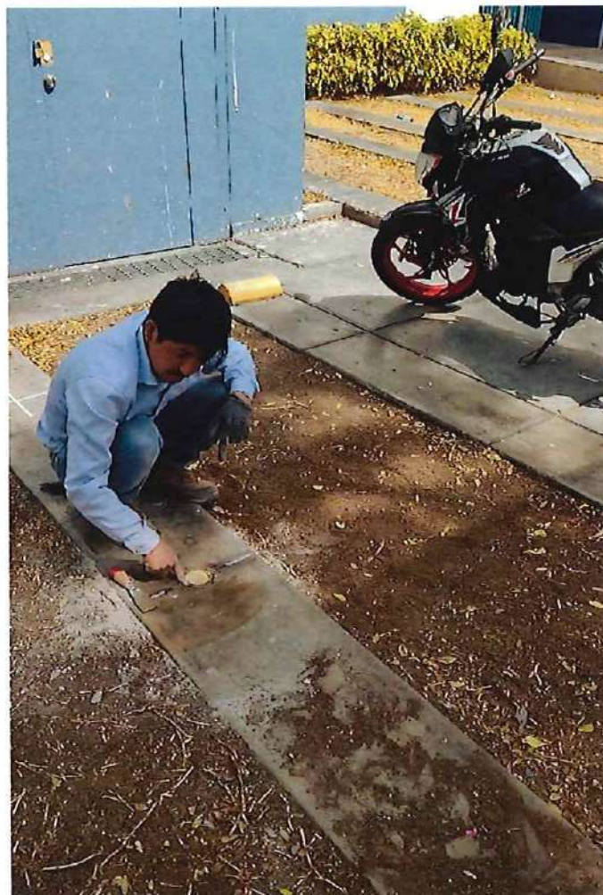
Ilustración 27: Incrustación del disco de bronce 2
