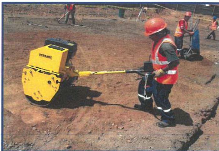
Fotografía N° 04: Si trabaja con una máquina ruidosa, pida orejeras o tapones
