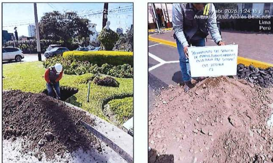
Figura N°15: Vista panorámica del terreno in situ propio de la zona a ejecutar.
