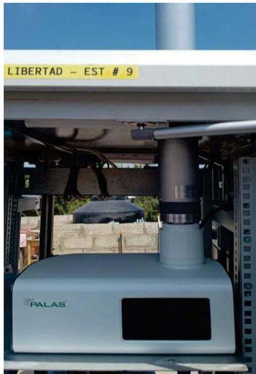
Imagen N° 02. Instalación del Equipo Fidas Smart 100E en la caseta de calidad del aire.
