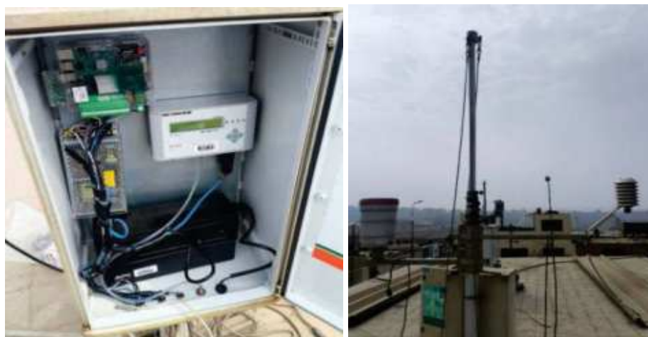
Figura 12. Conexión de cables al UPS
