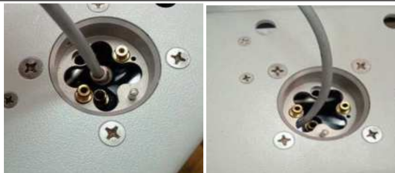
Figura 8. Ingreso de cable del sensor de temperatura y humedad por el orificio del soporte
