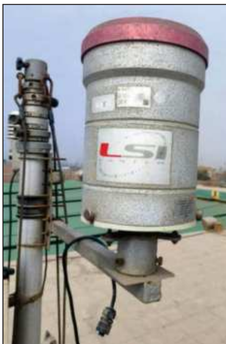
Figura 10. Instalación del pluviómetro
