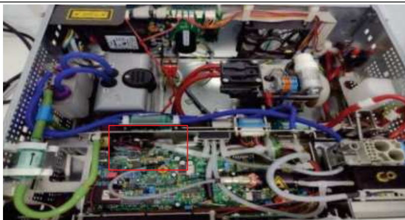
Figura 84. Descubierta de tapa mayor de monitor y ubicación de filtro BQ
