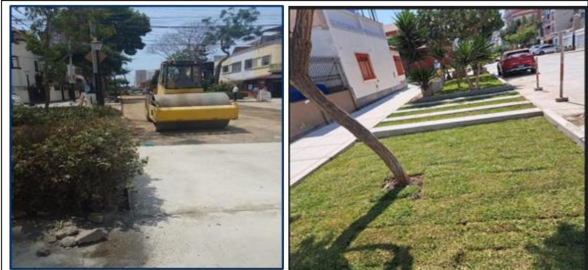
Martillo. – Demolición, conformación de base granular espesor  $e=0.10\text{m}$  y llenado de concreto  $f_c=175\text{kg/cm}^2$ , espesor  $e=0.10\text{m}$ ; área a intervenir  $664,31\text{m}^2$
