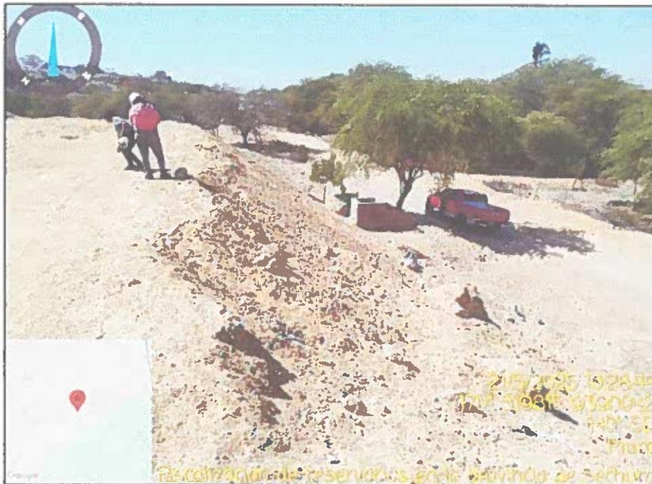
Fotografía N°01: Se evidencia talud sin conformar según parámetro de 2:1
