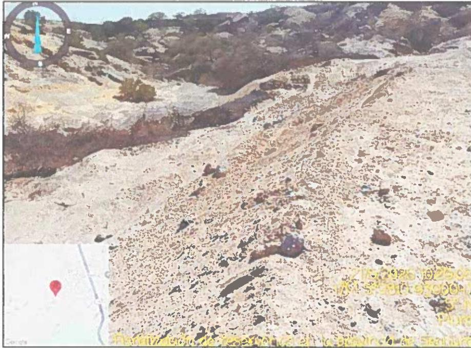
Fotografía N°02: Se evidencia talud sin conformar según parámetro de 2:1
