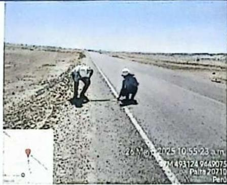
Verificación de ancho de berma en la progresiva 80+520
