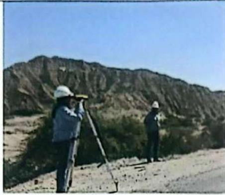
Imagen N°35: Verificación de pendiente longitudinal y bombeo en la progresiva 3+480 al 3+560.
