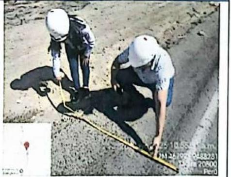
Verificación de ancho de berma en la progresiva 6+140
