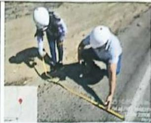
Imagen N°39: Verificación de ancho de berna en la progresiva 6+140
