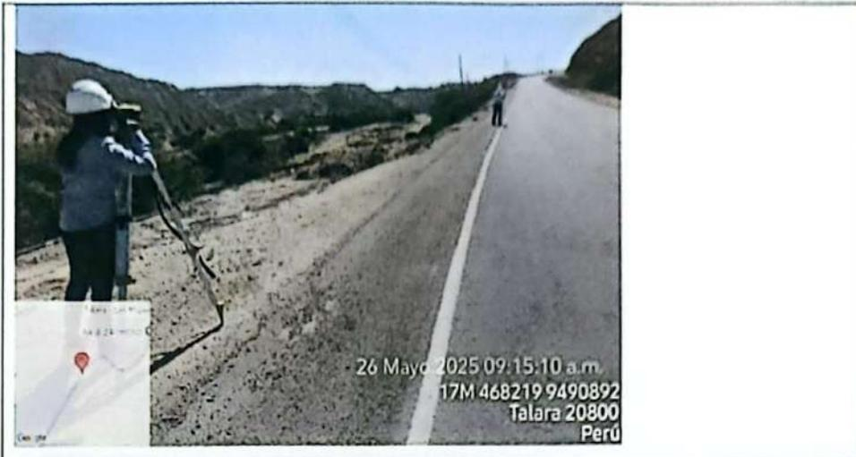
Imagen N°32: Verificación de pendiente longitudinal y bombeo entre las progresivas 3+400 y 3+480. Para el bombeo se comprobó el ancho de calzada y pendiente transversal según plano de secciones típicas.
