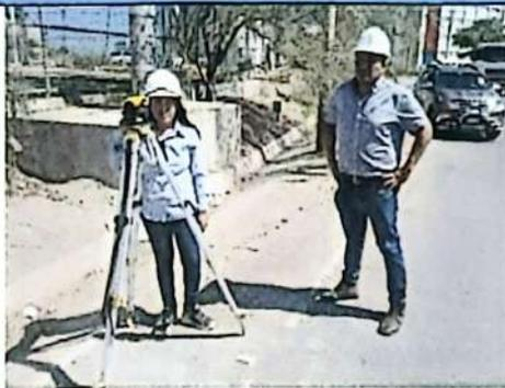
Imagen 30: Verificación de pendiente longitudinal y bombeo en la progresiva 0+000 al 0+040
