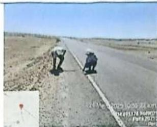
Imagen N°38: Verificación de ancho de berna en la progresiva 80+520
