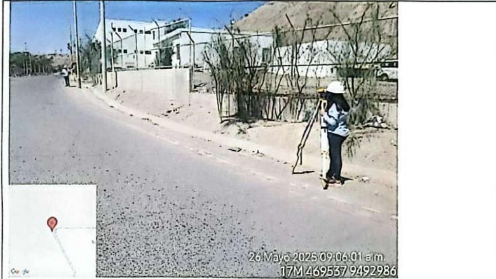
Verificación de pendiente longitudinal y bombeo en la progresiva 0+100 al 0+200
