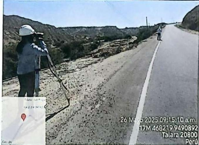
Verificación de pendiente longitudinal y bombeo entre las progresivas 3+400 y 3+480. Para el bombeo se comprobó el ancho de calzada y pendiente transversal según plano de secciones típicas.
