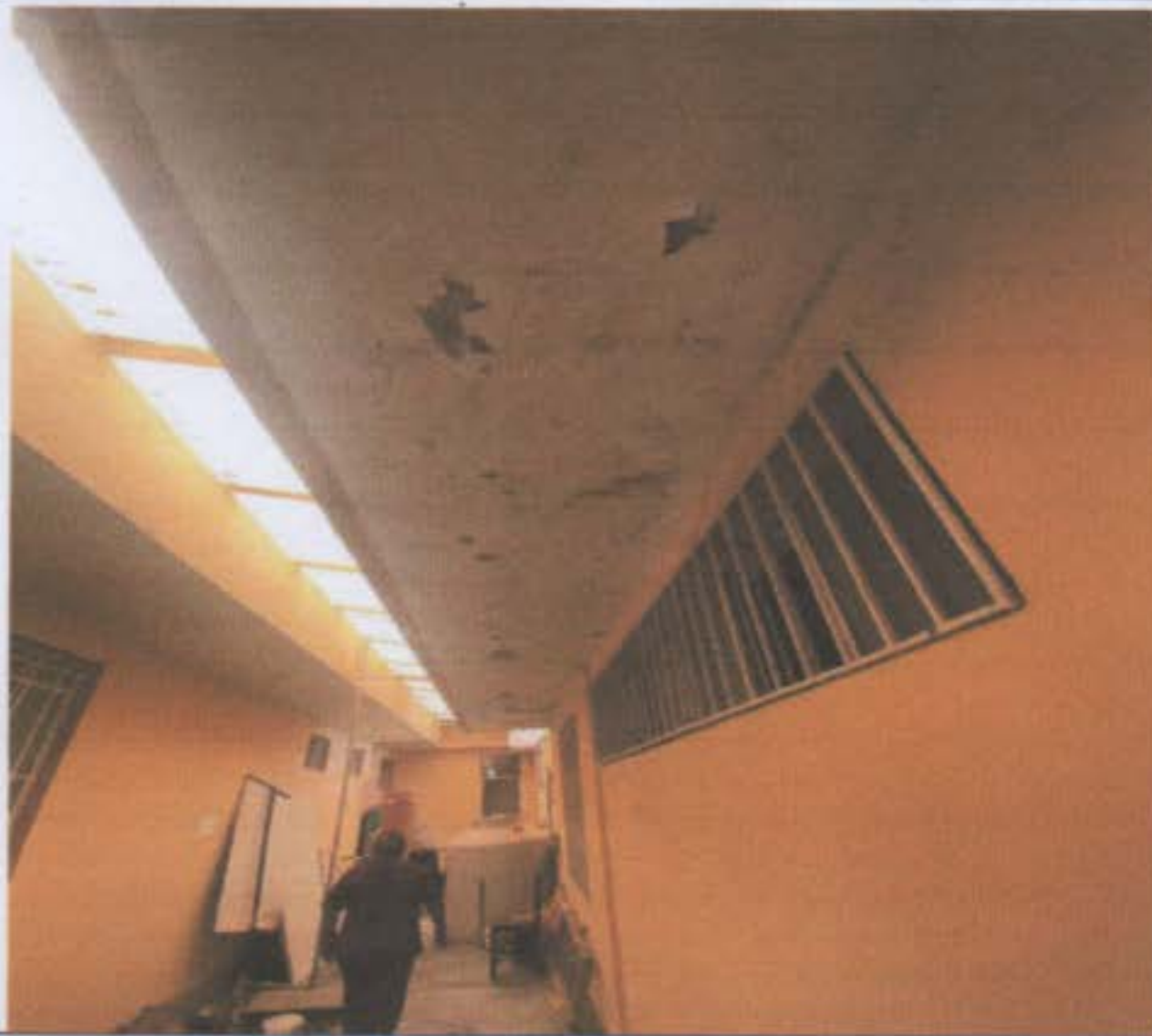
Interiores (Pasillo de conexión entre ambos bloques) del Centro de Salud Lobitos.
