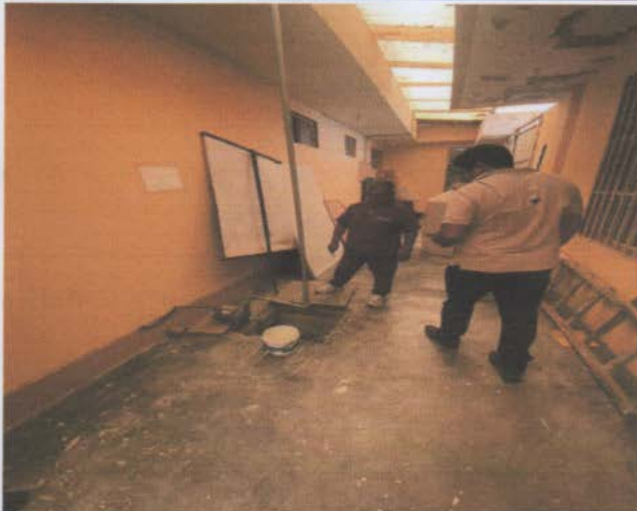
Interiores (ubicación de la cisterna de agua) del Centro de Salud Lobitos.
