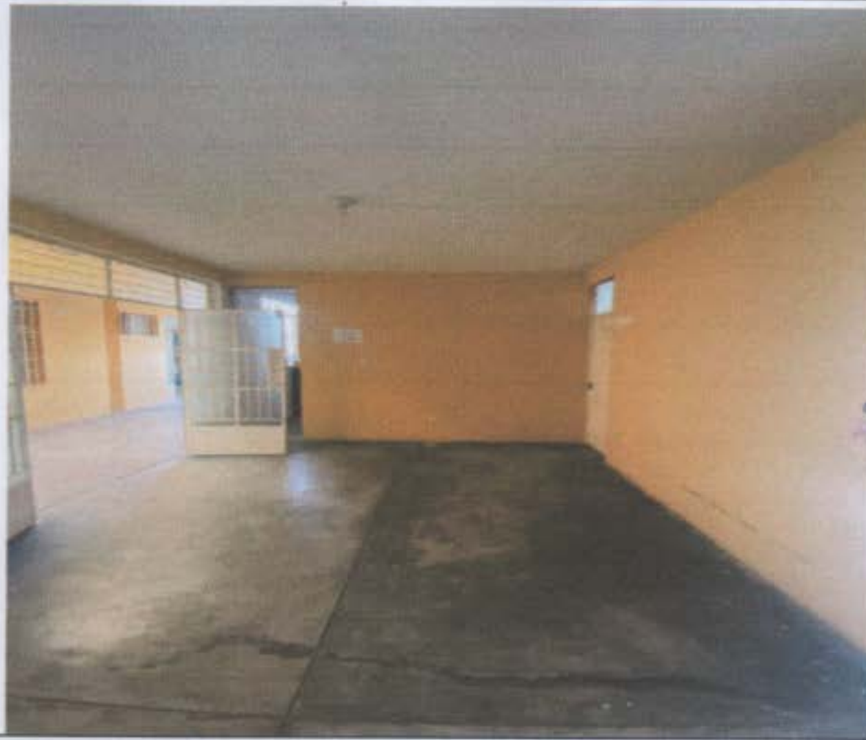
Interiores (Áreas de circulación) del Centro de Salud Lobitos.
