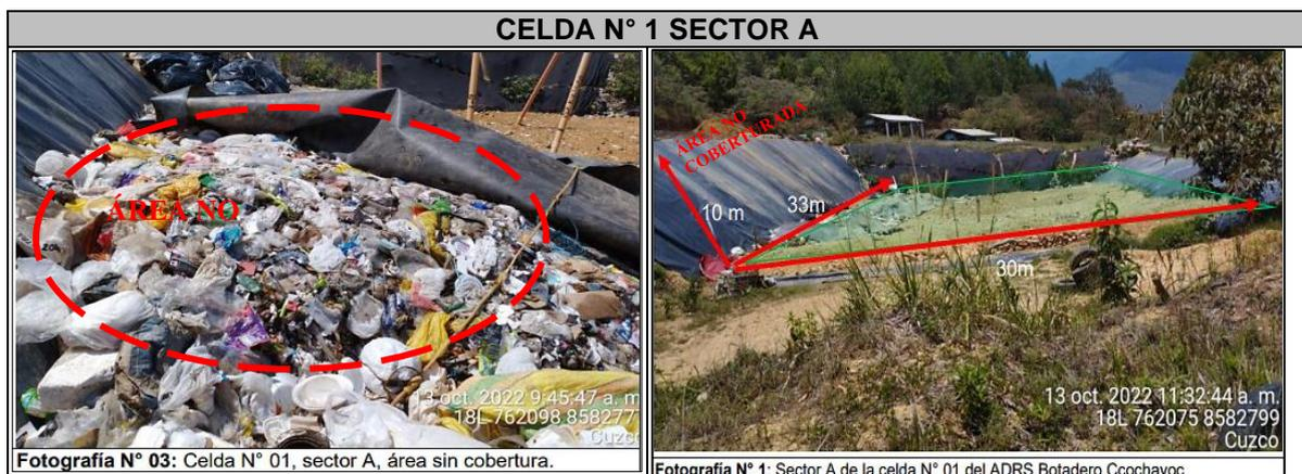
**Fuente:** Folio N° 5 del Informe Final de Supervisión N° 00053-2022-OEFA/ODES-CUS-OEI-LAC donde se visualiza en la Fotografía N° 3 residuos cubiertos provisionalmente con pedazos de geomembrana
