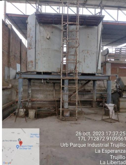
Recirculación de sulfuros (Tanque subterráneo de captación de efluente, tanque superficial de almacenamiento y reciclo, incluye bomba y tuberías)
