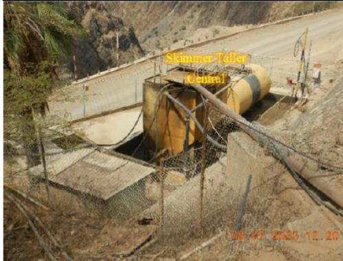
**Fotografía N° 3<sup>32</sup>:** Se observó el Skimmer del taller Central. Durante las acciones de supervisión se encontraba operativo.
