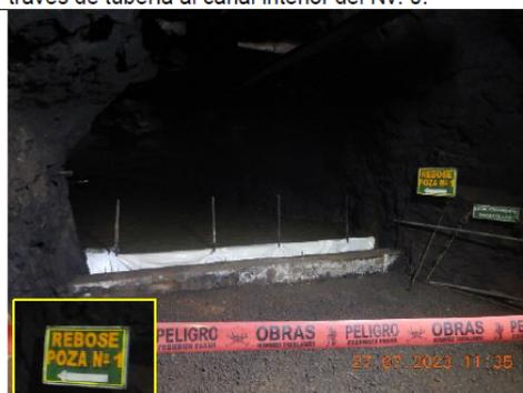
Fotografía N° 18<sup>47</sup>: Rebose de la Poza de Sedimentación N° 1 ubicada interior mina en el Nv. 0.
