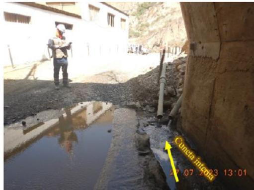
**Fotografía N° 6<sup>35</sup>:** Otra vista de la Bocamina Nv. 10 contaba con una cuneta interna para drenaje de agua de mina por la cual se conducía un flujo de agua de interior mina; asimismo, se observó que a dicha cuneta descargaban flujos de agua que provenían de los sistemas de tratamiento de agua de los talleres “Skimmer Nv. 28” y “Skimmer Taller Central”, mediante dos tuberías de 4”.
