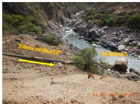
**Fotografía N° 32<sup>61</sup>:** La tubería metálica de 24" del Nv. 0 llega hasta el punto de descarga de efluente minero-metalúrgico codificado como E-2 (807) con vertimiento hacia el río Mantaro.
