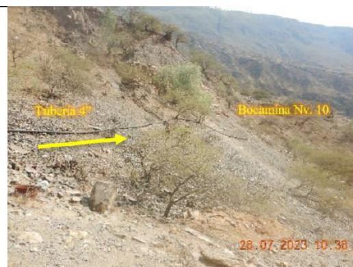
**Fotografía N° 2<sup>31</sup>:** Se observó la tubería de 4" que proviene del Skimmer Nv 28, llega a la bocamina Nv. 10.
