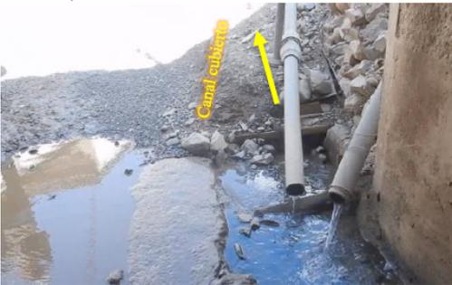
**Fotografía N° 7<sup>36</sup>:** En la captura de segundo 29 del video, se observó que el agua mezclada continúa su flujo mediante un canal externo cubierto en dirección a la Poza de Sedimentación N° 1.
