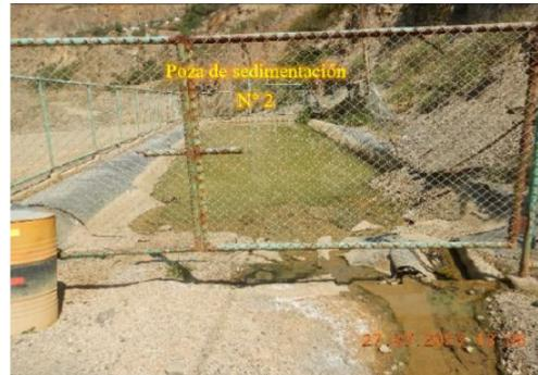
**Fotografía N° 10<sup>39</sup>:** La Poza de Sedimentación N° 2 del Nv. 10 (8 m de ancho x 30 m de largo) se encontraba revestida con geomembrana.
