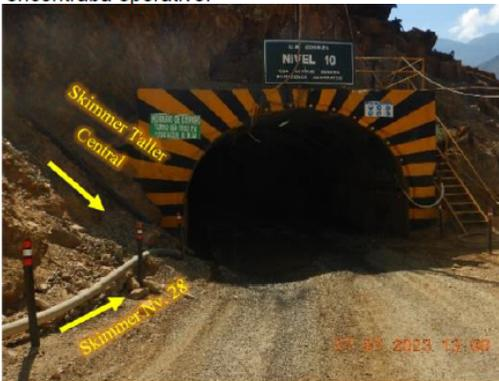
**Fotografía N° 5<sup>34</sup>:** Se observó que la Bocamina Nv. 10 contaba con una cuneta para drenaje de agua de mina por la cual se conducía un flujo de agua de interior mina; asimismo, se observó que a dicha cuneta descargaban flujos de agua que provenían de los sistemas de tratamiento de agua de los talleres “Skimmer Nv. 28” y “Skimmer Taller Central”, mediante dos tuberías de 4”.
