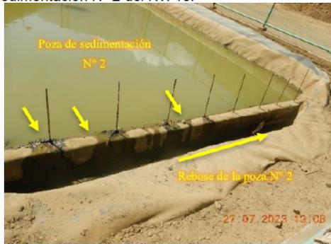
**Fotografía N° 11<sup>40</sup>:** Se observó el punto de rebose de la Poza de Sedimentación N° 2 del Nv. 10 es captado por una tubería HDPE de 4”.
