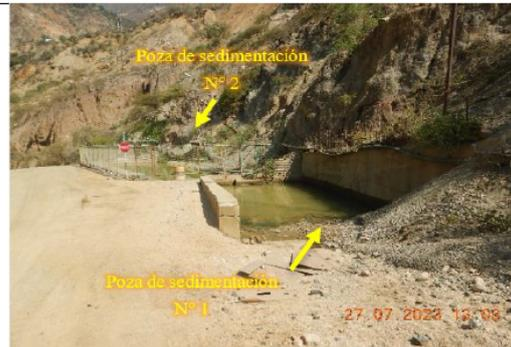
**Fotografía N° 8<sup>37</sup>:** Se observó que el agua es conducida a la Poza de sedimentación N° 1 (6 m de ancho x 10 m de largo) de concreto, además a la salida de esta Poza, se observó que el agua rebotaba por un canal de concreto luego era derivada hacia la Poza de Sedimentación N° 2.
