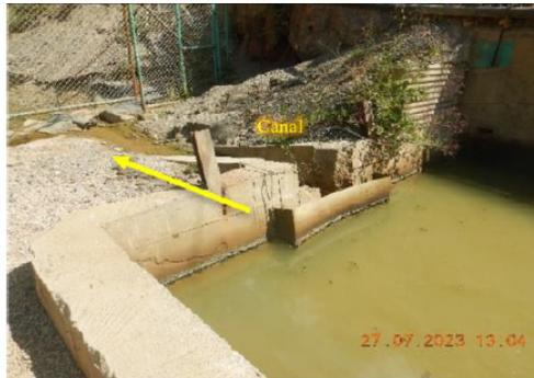
**Fotografía N° 9<sup>38</sup>:** A la salida de la Poza de Sedimentación 1 se observó que el agua rebosaba por un canal de concreto en la cual se le dosificaba floculante y luego era derivada hacia la Poza de Sedimentación N° 2 del Nv. 10.
