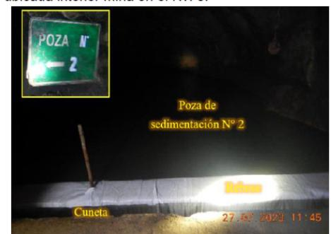
Fotografía N° 19<sup>48</sup>: Se observa la Poza de Sedimentación N° 2 y el rebose de agua de mina por la cuneta de drenaje hacia la tubería de 24" ubicada en Nv. 0.
