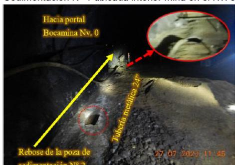
Fotografía N° 20<sup>49</sup>: El flujo de agua proveniente de cuneta que deriva dicha agua hacia la tubería metálica de 24" del Nv. 0, dirigido hacia el portal Bocamina Nv. 0. Nótese que la tubería metálica se encuentra perforada con agujeros rectangulares.
