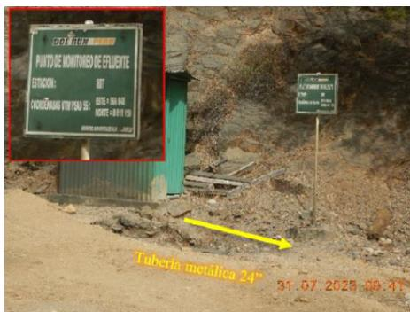
**Fotografía N° 31<sup>60</sup>:** Finalmente, el agua de interior mina que proviene de los sistemas de tratamiento de agua de mina del Nv. 10 y del Nv. 0, descarga en la tubería metálica de 24" del Nv. 0 hasta llegar al punto de descarga de efluente minero-metalúrgico codificado como E-2 (807) con vertimiento hacia el río Mantaro.
