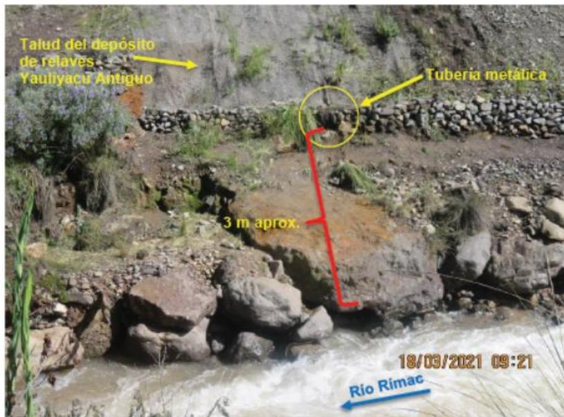
Fotografía N° 4<sup>34</sup>: Extremo de la tubería metálica ubicada en la base del talud del depósito de relaves Yauliyacu Antigua, a aproximadamente 3 metros del margen derecho del cauce del río Rímac.
