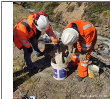
Fotografía N° 20: Preparación del grout (concreto líquido) para la instalación del sensor.
