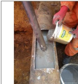
Fotografía N° 22: Relleno de tubería metálica con grout (concreto líquido), con el sensor en el interior.
