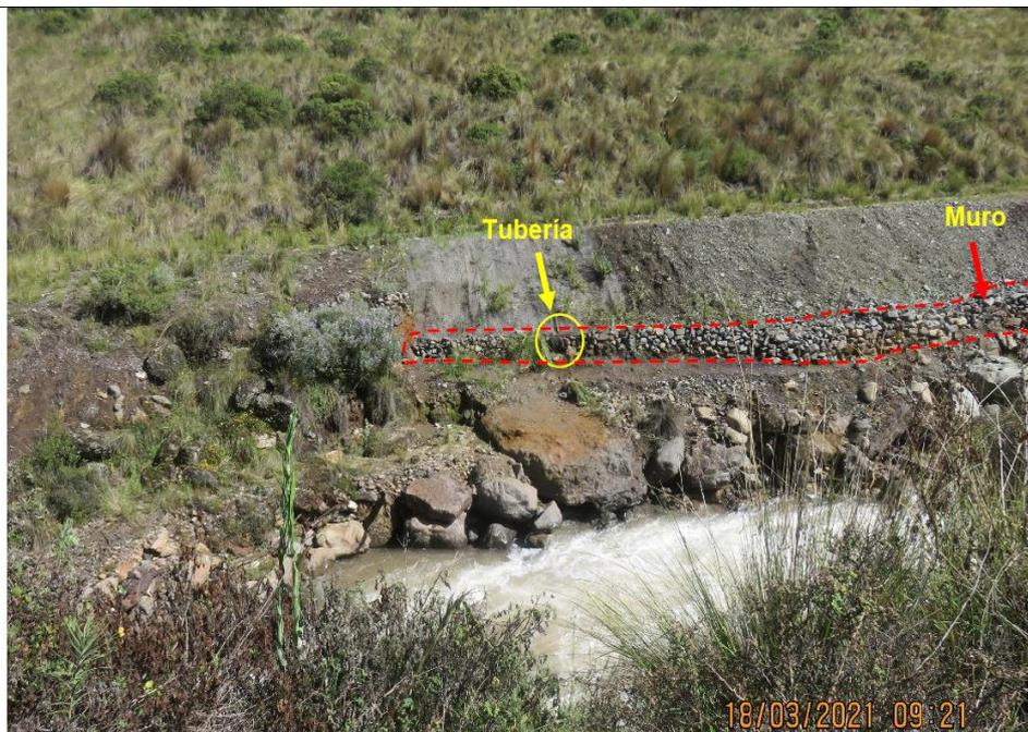
Fotografía N° 24<sup>61</sup>: Vista del muro de piedras y tubería desde la margen izquierda del río Rímac.
