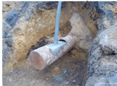
Fotografía N° 23: Vista final de la instalación del sensor en la tubería metálica.
