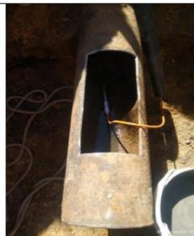
Fotografía N° 21: Posicionamiento del sensor para su instalación dentro de tubería metálica.
