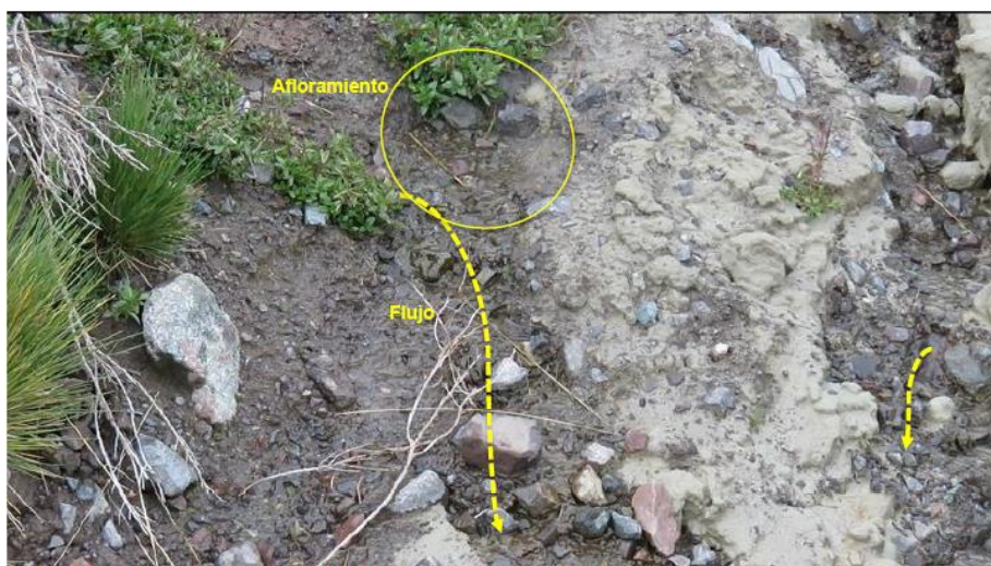
Fotografía N° 163 296 : Otra vista de un afloramiento de adyacente al dique del depósito de relaves Chinchán, en las coordenadas UTM WGS84 Zona 18365181E; 8717392N.
