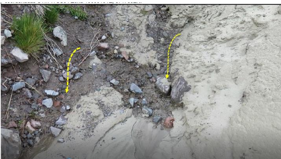
Fotografía N° 164 299 : Otra vista del agua que discurre del afloramiento adyacente al dique del depósito de relaves Chinchán, en las coordenadas UTM WGS84 Zona 18365181E; 8717392N, se observa que el agua estaría aflorando por el talud del acceso y esta tendría contacto con el material del dique de la relavera.
