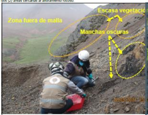
Fotografía N° 4 35 : Vista de la zona fuera de la malla de seguridad de la chimenea H1-RB1- SAN JUAN, se observa manchas oscuras en la roca y en el suelo.
