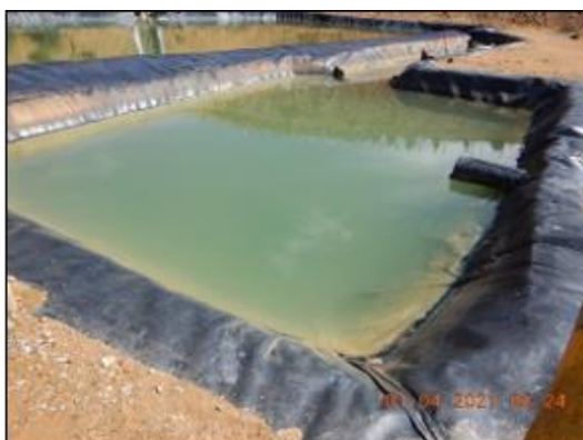
Fotografía N° 13: Vista de la caja de ingreso, que presentaba un canal de ingreso proveniente de la poza de sedimentación N° 2 y una tubería de salida en dirección del humedal aerobio. (Ver archivo: DSCN7981).
