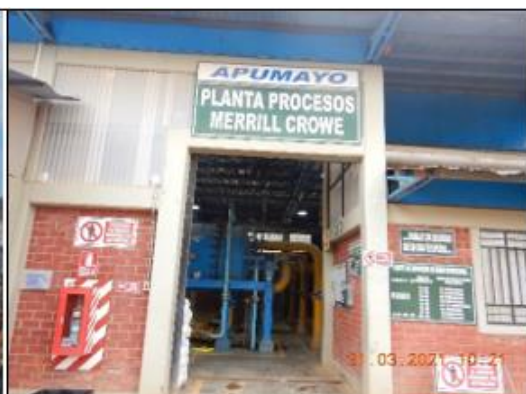
Fotografía N° 02: Vista de la planta merrill crowe, que se encontraba conformada por paredes, techo de calamina y piso de concreto. (Ver archivo: DSCN8572).
