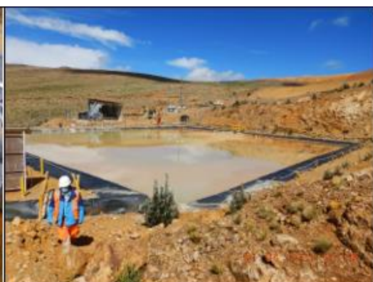
Fotografía N° 14: Vista de la poza de sedimentación N° 1, que presentaba un canal de ingreso proveniente del área donde se ubicaba el tanque neutralizador y un canal de salida en dirección la poza de sedimentación N° 2 (Ver archivo: DSCN8013).
