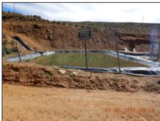
Fotografía N° 15: Vista de la poza de sedimentación N° 2, que presentaba un canal de ingreso proveniente de dicha poza y un canal de salida en dirección de la caja de ingreso (Ver archivo: DSCN7990).
