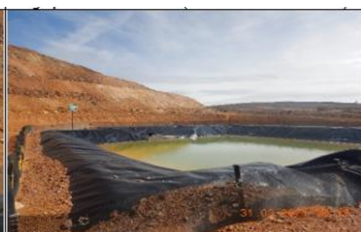
Fotografía N° 47: Vista de la poza de monitoreo de subdrenaje del botadero de desmonte Ayahuanca, la cual se encontraba revestida con geomembrana. (Ver archivo: DSCN8840).
