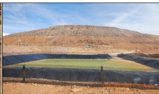
Fotografía N° 45: Vista de la poza de sedimentación del botadero de desmonte Ayahuanca, la cual se encontraba revestida con geomembrana y sus dimensiones eran de aproximadamente 15 m de largo por 15 m de ancho. (Ver archivo: DSCN8833).
