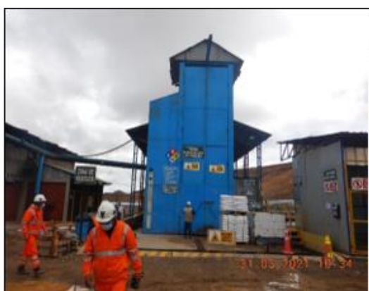
Fotografía N° 05: Vista de torre de precipitación de cianuro, la cual se encontraba sobre una losa de concreto armado, techo metálico y con un letrero de identificación (Ver archivo: DSCN7720).
