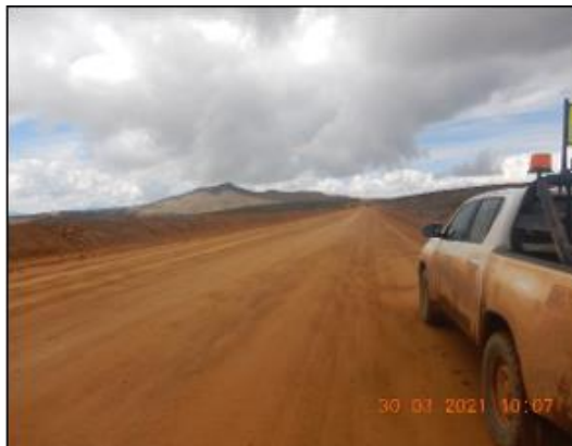
Fotografía N° 40: Vista del camino minero (vía de acceso de aproximadamente 15 m de ancho de rodaje), la cual presentaba una berma de 1.5 m de altura y una cuneta construida en tierra, ambas ubicadas al lado extremo de la referida vía. (Ver archivo: DSCN8753).
