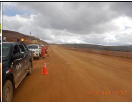
Fotografía N° 41: Otra vista del camino minero (vía de acceso de aproximadamente 15 m de ancho de rodaje) (Ver archivo: DSCN8768).
