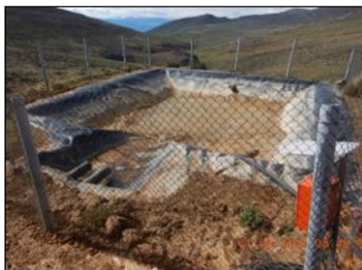
Fotografía N° 11: Vista de la poza de subdrenaje de la planta de tratamiento 1 - Wetland, que se encontraba revestida con geomembrana, con dimensiones de 12 metros de ancho por 12 metros de largo, aproximadamente (Ver archivo: DSCN7931).
