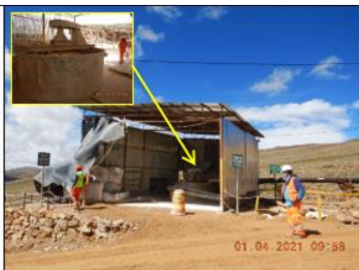
Fotografía N° 16: Vista del área donde se encontraba el tanque de neutralización. En el interior de dicha área se observó costales big bag, un tanque reactor de aproximadamente 26 m 3 , una tubería de ingreso proveniente de la poza de monitoreo de subdrenaje del depósito de desmonte 1 (sector Apumayo) y tuberías de salida en dirección de la poza de sedimentación N° 1. (Ver archivo: DSCN8033).
