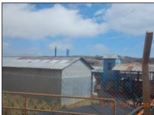
Fotografía N° 01: Vista de la planta merrill crowe, ubicada en las coordenadas UTM WGS 84 N 8 346 165 y N 616 051 (Ver archivo: DSCN8572).
