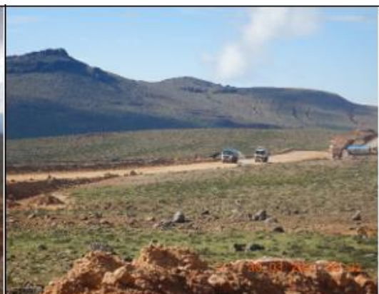
Fotografía N° 43: Vista del regado del camino minero (vía de acceso) mediante camiones cisterna y mantenimiento a través de equipo pesado (motoniveladora y rodillo) (Ver archivo: DSCN8665).
