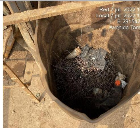
**Fotografía TC- 00041:** Se observa el acopio de diversos residuos en condición de mezcla (sin segregar): botellas de plástico, waypes impregnados con hidrocarburos y alambres metálicos.
