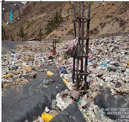
Fotografía N° 01: Vista del marco de madera para los drenes de gases. TimePhoto\_20241028\_123831
