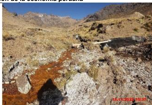
Fotografía N° 29 (20221114_153738). - Vista de la tubería de descarga final hacia la quebrada Caballune.
