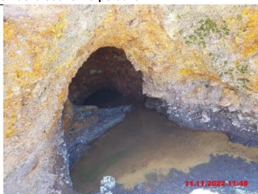
Fotografía N° 23 (20221111_114835). – Otra vista de la bocamina 8746 con presencia de drenaje de mina.
