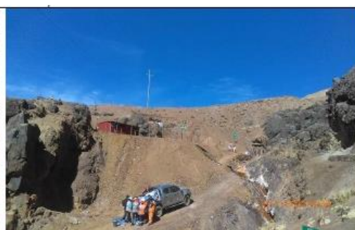
Fotografía N° 19 (IMAG1126_timestamp). - Otra vista de la quebrada Mercedes, aguas abajo de la bocamina 8740, la cual mantiene sedimentos acumulado en su cauce, los cuales fueron advertidos en el año 2021.
