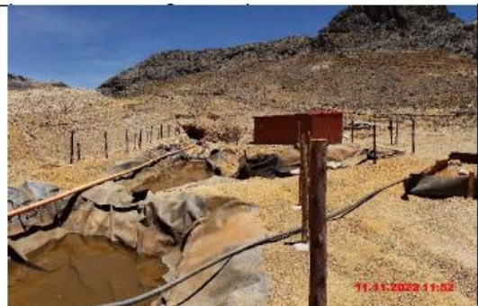
Fotografía N° 26 (20221111_115215).-. Vista del sistema de pozas por donde discurría el drenaje de mina, los cuales se encuentra impermeabilizada con geomembrana.
