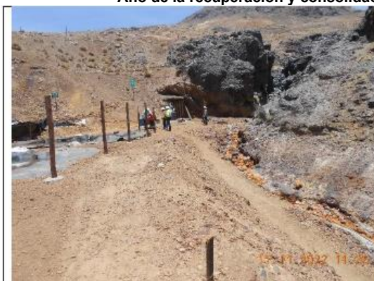
Fotografía N° 16 (DSCN0100). - Vista de la quebrada Mercedes, el cual mantiene sedimentos acumulado en su cauce, los cuales fueron advertidos en el año 2021.
