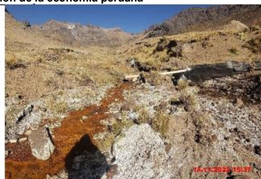
Fotografía N° 29 (20221114_153738). - Vista de la tubería de descarga final hacia la quebrada Caballune.
