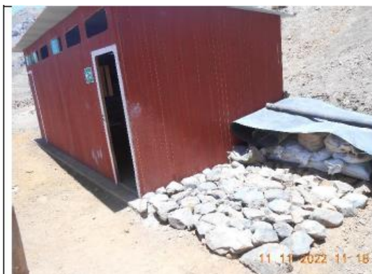
Fotografía N° 14 (DSCN0095). - Vista del almacén de insumos químicos para tratamiento de drenaje de la bocamina 8740.
