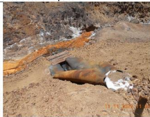
Fotografía N° 17 (DSCN0099). - Otra vista de la quebrada Mercedes, aguas abajo de la bocamina 8740, la cual mantiene sedimentos acumulado en su cauce, los cuales fueron advertidos en el año 2021.
