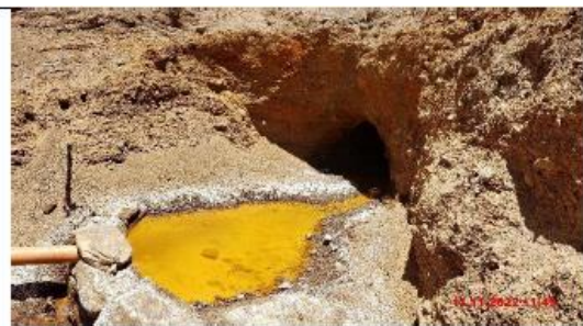
Fotografía N° 24 (20221111_114916).- Bocamina 8746, vista de la primera captación de agua de mina, el cual es conducido por una tubería de 4 pulgadas aproximadamente; a través de la cual es conducida aguas abajo a un sistema de pozas para tratamiento previo a su descarga en la quebrada Caballume.
