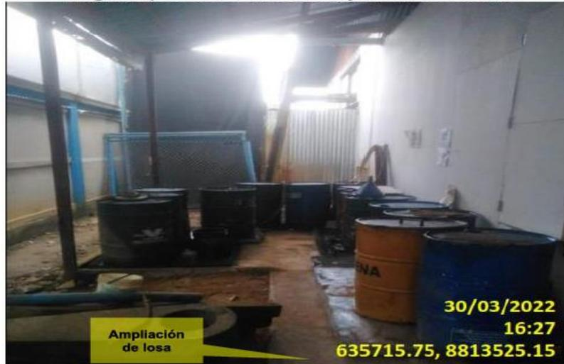
Se observa que el administrado realizó tareas de ampliación del piso de concreto donde se almacenan los 9 cilindros que contienen aceites usados.
