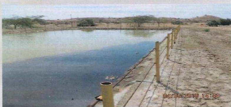
Se observa la Poza de Evaporación de mayor capacidad de la Batería 320, que habría alcanzado su máxima capacidad, así como una película de hidrocarburo en la superficie del espejo de agua de producción. Observe rastros de afectación de suelos por la infiltración o reboce de dichas aguas.
