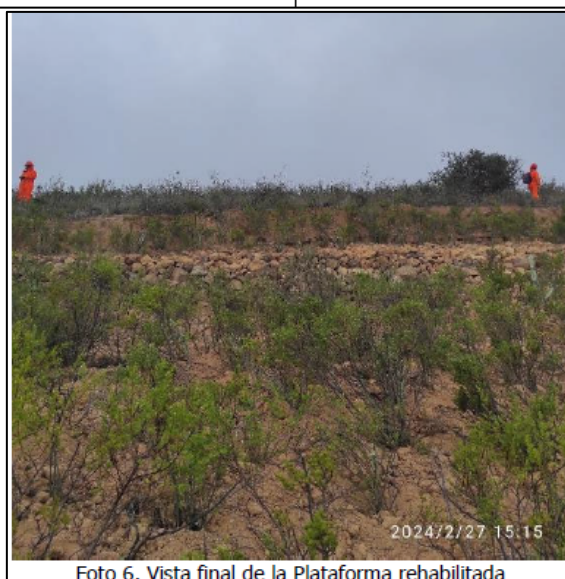
Foto 6. Vista final de la Plataforma rehabilitada
