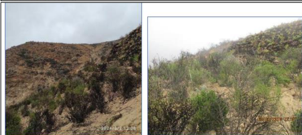
Foto 6. Vista de la Plataforma revegetada con especies locales y talud estabilizada.
