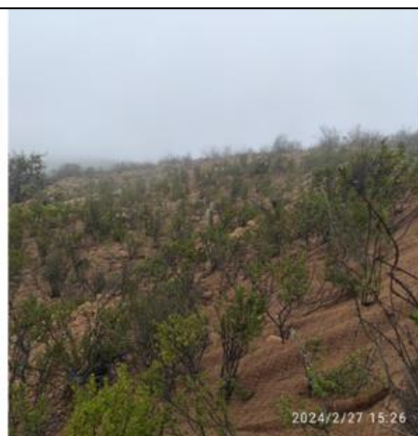
Foto 2. Vista de la revegetación desde la parte superior, con el empleo de biomanta (fibra de coco) en el talud sobranante.
