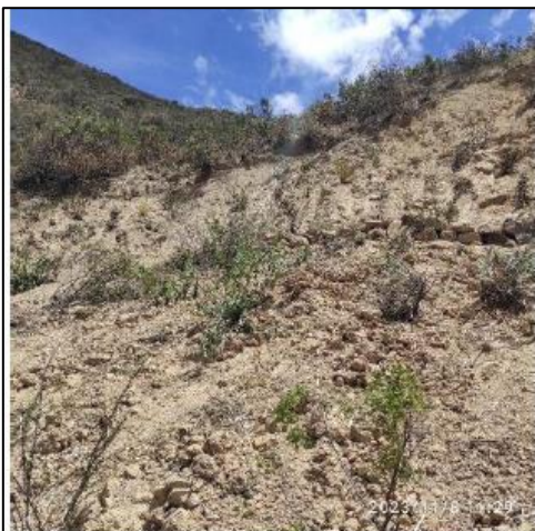
Foto 1. Vista del talud, antes de las actividades de revegetación.
