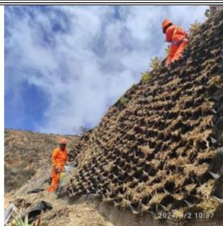
Foto 3. Vista del talud con la geocelda e incorporación de mulch y suelos.
