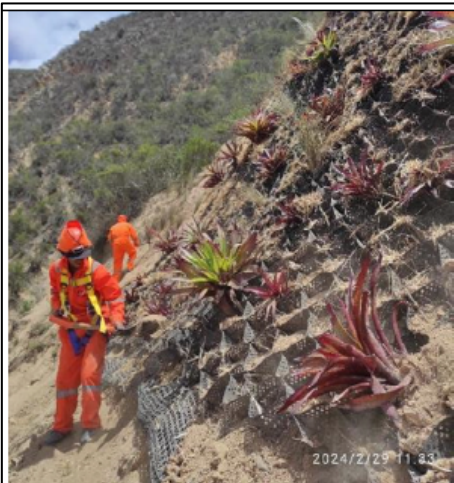
Foto 3. Vista de la geocelda con la inclusión de suelos, mulch y especies de epifitas locales.
