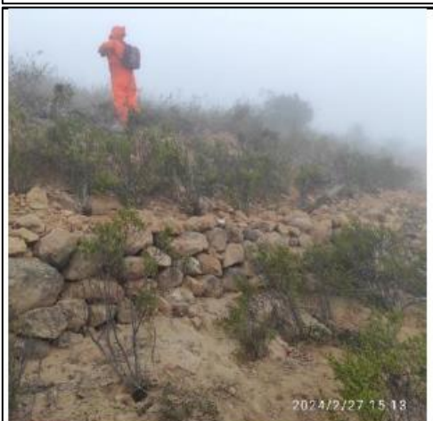
Foto 3. Vista del muro de piedras a manera de terraza para la reducción del talud, en la cual se realizó la revegetación con especies locales.
