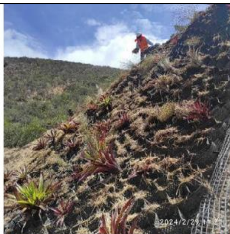
Foto 2. Vista de la estabilización del talud inclinado, mediante el empleo de geomalla y geocelda.
