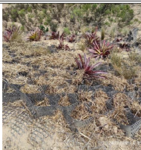
Fotos 4. Vista del talud desde la parte superior, en la cual se observa el proceso de estabilización con geomallas.
