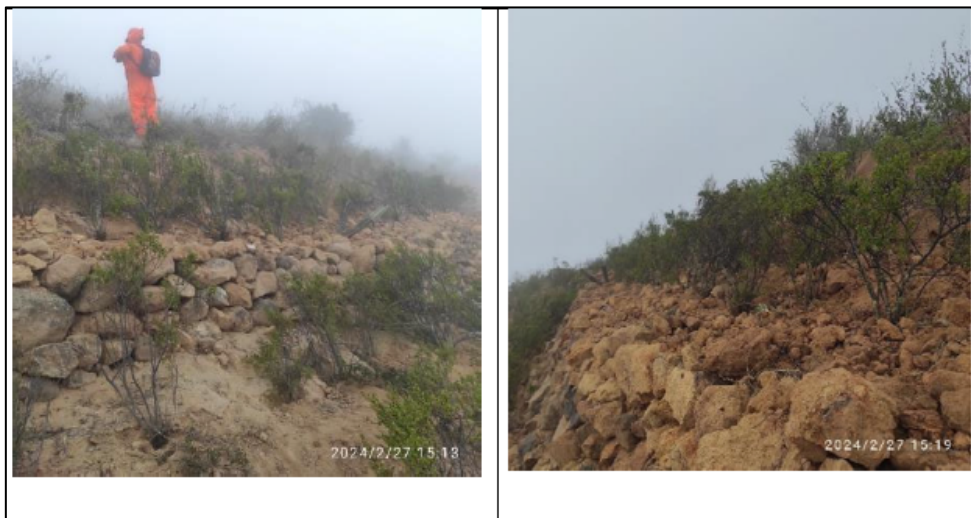
Foto 3. Vista del muro de piedras a manera de terraza para la reducción del talud, en la cual se realizó la revegetación con especies locales.
