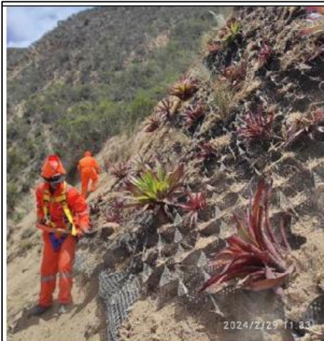
Foto 3. Vista de la geocelda con la inclusión de suelos, mulch y especies de epífitas locales.
