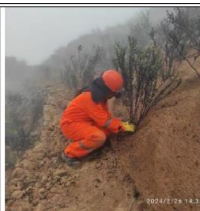
Foto 2. Vista del empleo de la biomanta sobre el pequeño talud en el proceso de estabilización y revegetación.
