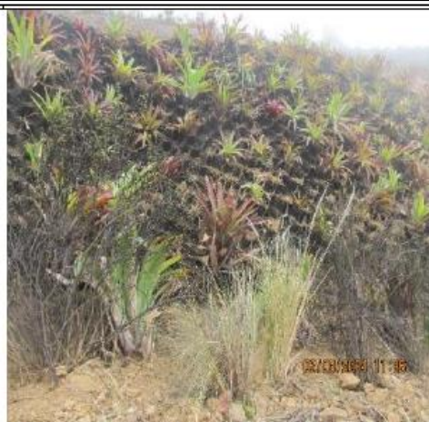
Foto 4. Vista de la geocelda en el talud con plantaciones de epífitas locales.
