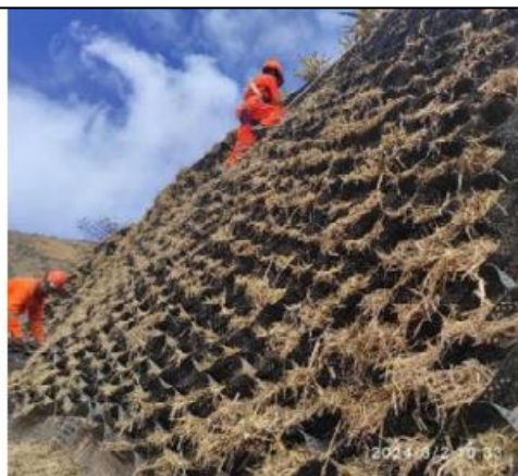
Foto 2. Vista del acondicionamiento de la geomalla y geocelda en el proceso de estabilización del talud con pendiente inclinada.
