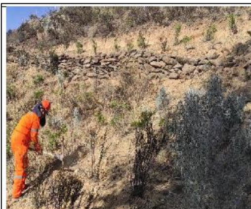
Foto 1. Vista inicial del pequeño talud sobre el muro de piedras.
