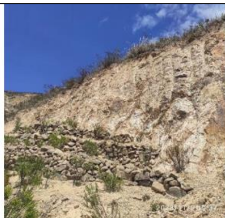
Foto 1. Vista inicial del talud presente en la plataforma.
