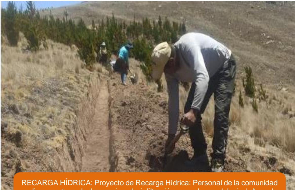
**RECARGA HÍDRICA:** Proyecto de Recarga Hídrica: Personal de la comunidad realiza apertura de las zanjas de infiltración con el uso del nivel A en la comunidad de Querora del potrero 1 – Cusco
