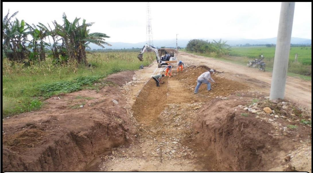
**OBRA: "MEJORAMIENTO DEL SERVICIO DE AGUA DEL SISTEMA DE RIEGO LATERAL 40 MARGEN IZQUIERDA IRRIGACIÓN SISA, DISTRITO DE CASPIZAPA, PROVINCIA DE PICOTA, REGIÓN SAN MARTIN", EN EXCAVACIÓN DE LA CAJA DEL CANAL, PREVIA COMPACTACIÓN.**
