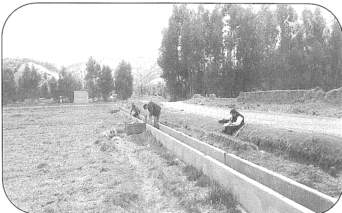
MEJORAMIENTO Y AMPLIACION SISTEMA RIEGO SAN PEDRO DE SAÑO, HUANCAYO. JUNIN
